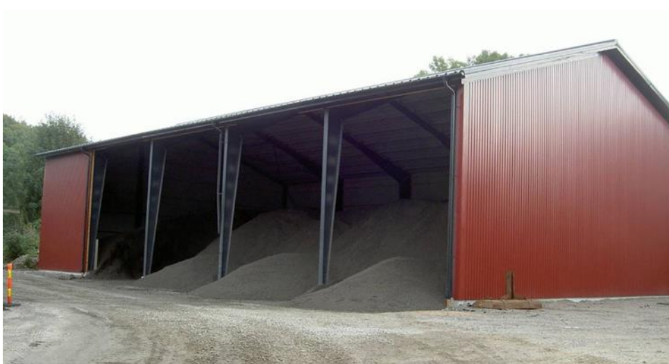
Figur 9. Förvaring av stenmaterial under tak (Skanska).
