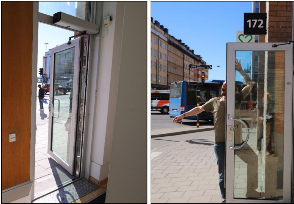
Figur 2. Exempelutformning av dörr som slår ut mot livlig trottoar.
