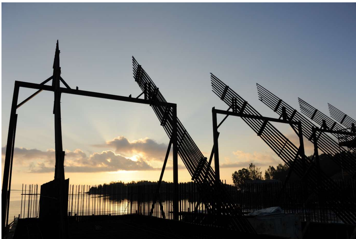
Figur B.1: L-stöd i form av vägg och kontrefort som gjuts på landbacken för att sedan sänkas ned. Foto: Kjell Wallin.
