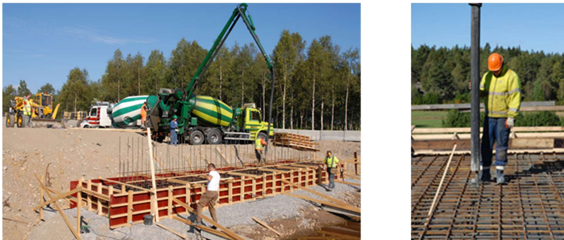
Figur 14.1: Gjutning med SKB (Simonsson, 2011).
