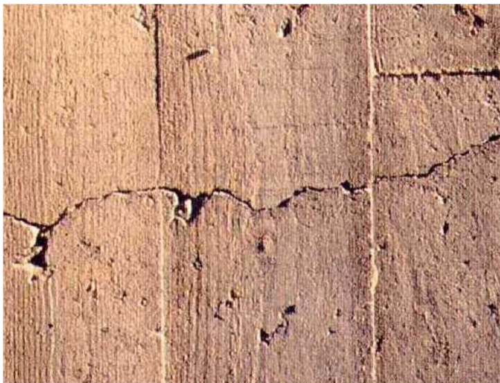
Figur 18.1: Exempel på horisontellt gjutveck som visar gränsen mellan två SKB-lass.
