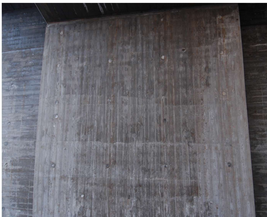
Figur 19.1: Gjutning med anläggningsbetong innehållande Limus 25. Notera tendensen till gjutveck. Foto: Kjell Wallin.
