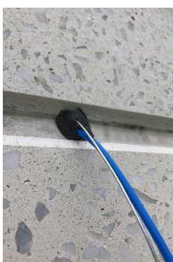
Figur 14. Söderfasad. Mätslang monterad genom fog bakom fogmassa och bottningslist.
