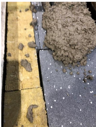
Figur 6. Exempel på gjutning av betongsandwichelement. Pågående gjutning av den andra betongskivan. I denna del av elementet användes mineralullsisolering närmast fönsteröppning och i övrigt EPS. (Olsson, 2021)
