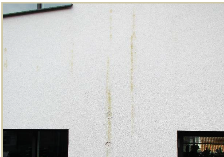
Bild 1.1 Missfärgad fasadputs med bakomliggande skivor och luftspalt. Foto: Byggeskadefonden Danmark [2].
