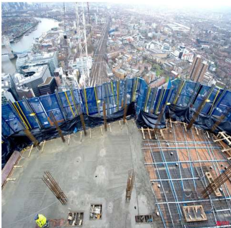
Figur 16. Arbetsställe för gjutning av bjälklag på hög höjd i The Shard, där säkerhetsskärmarna syns tydligt. Foto Christer Isgren OtB Concrete.
