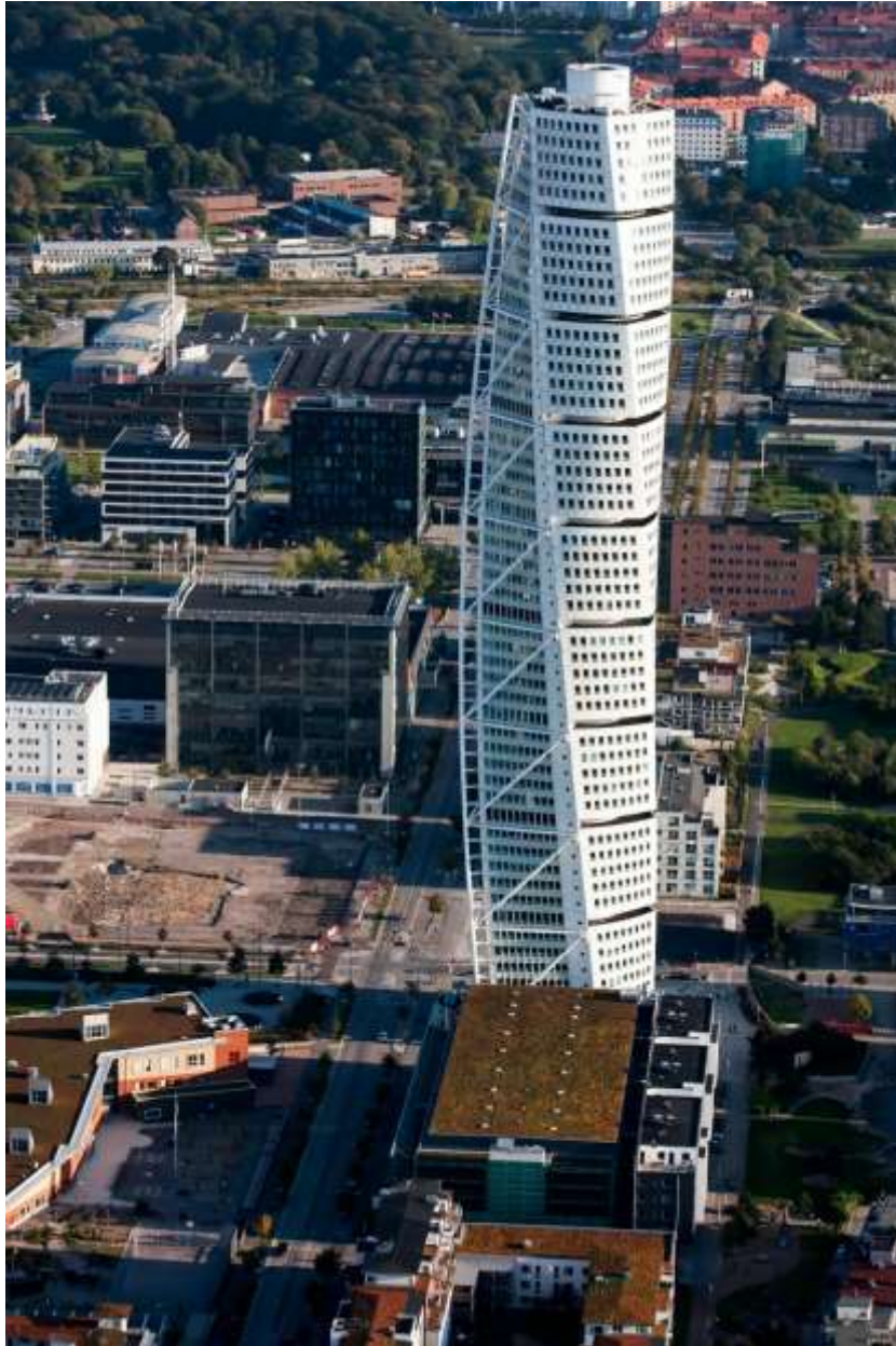
Figur 18. Turning Torso där det yttre fackverket är tydligt synligt. Foto nedladdat från Wikipedia.
