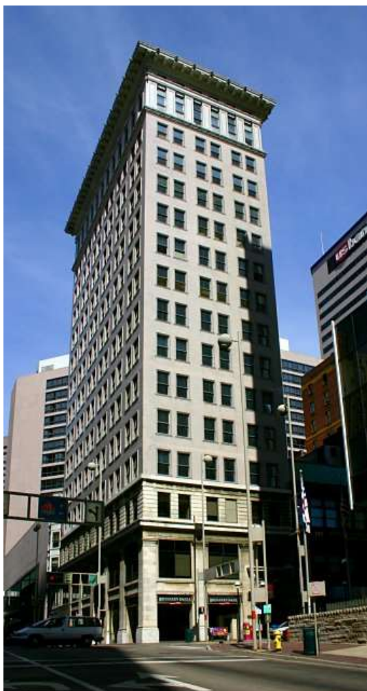
Figur 2. Ingalls Building belägen i Cincinnati, som var den första riktiga skyskrapan som uppfördes i armerad betong.
