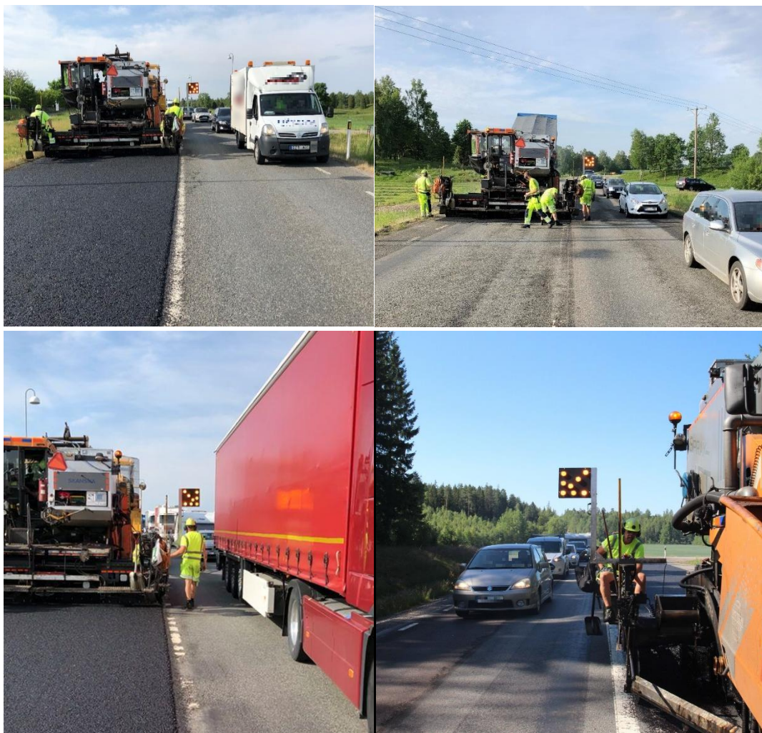
Figur 4. Visualisering av ljustavlan i användande under fyra oberoende vägarbetsplatser. Vägarbetarna har utrymme att med lätthet gå bredvid maskinen tack vare tavlans placering.
