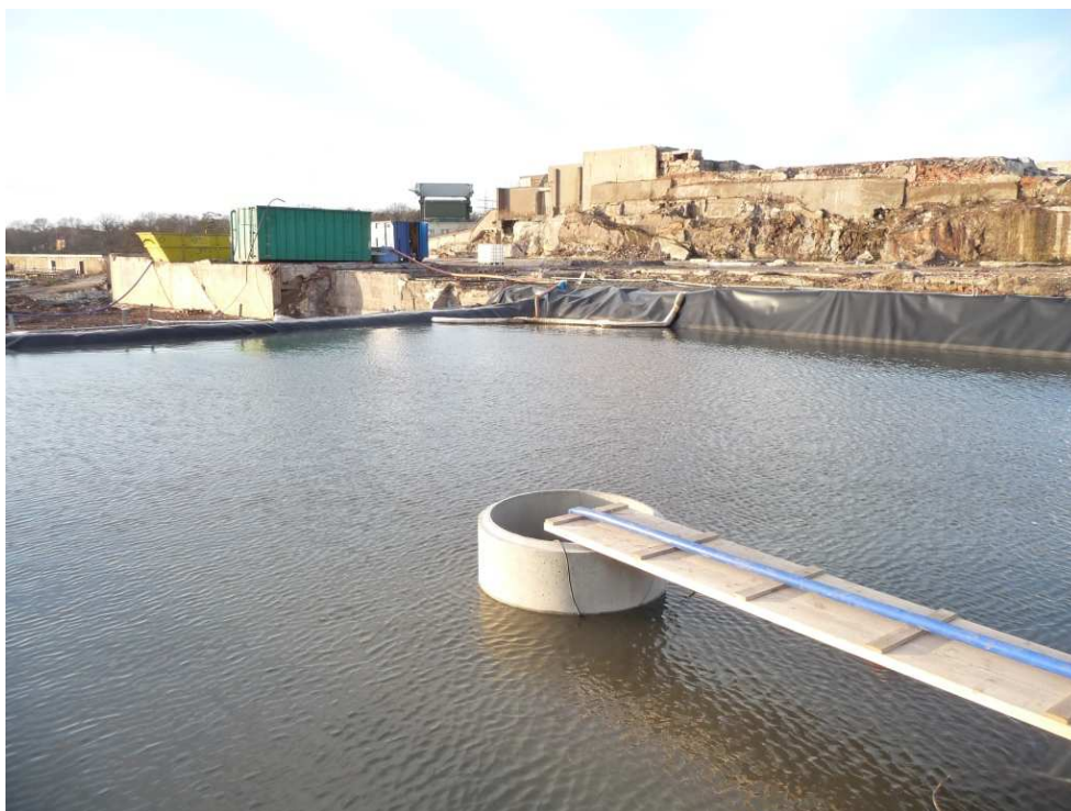
Figur 5.2. Sedimenteringsdamm vid marksanering
