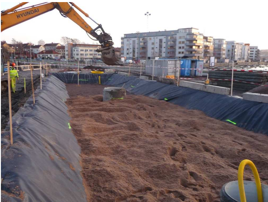
Figur 5.5. Byggnation av långsamfilter för förorenat länsvatten, Göteborg
