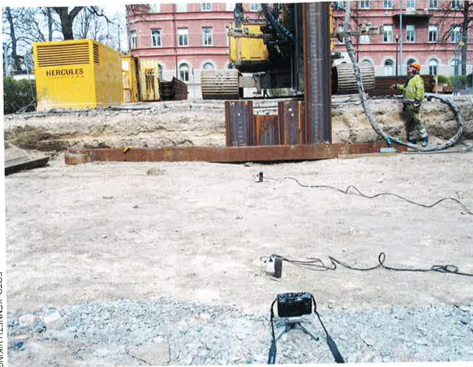
Figur 9: Kamera, geofoner och spontlinje.
