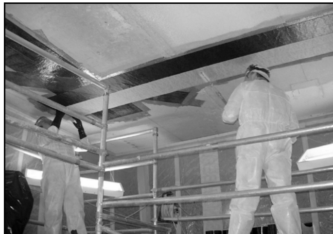
Figur 2. Förstärkning av ett betongbjälklag med kolfiberväv runt öppningen innan en ny öppning görs för ett ventilationsschakt. Foto Björn Täljsten 2002.
