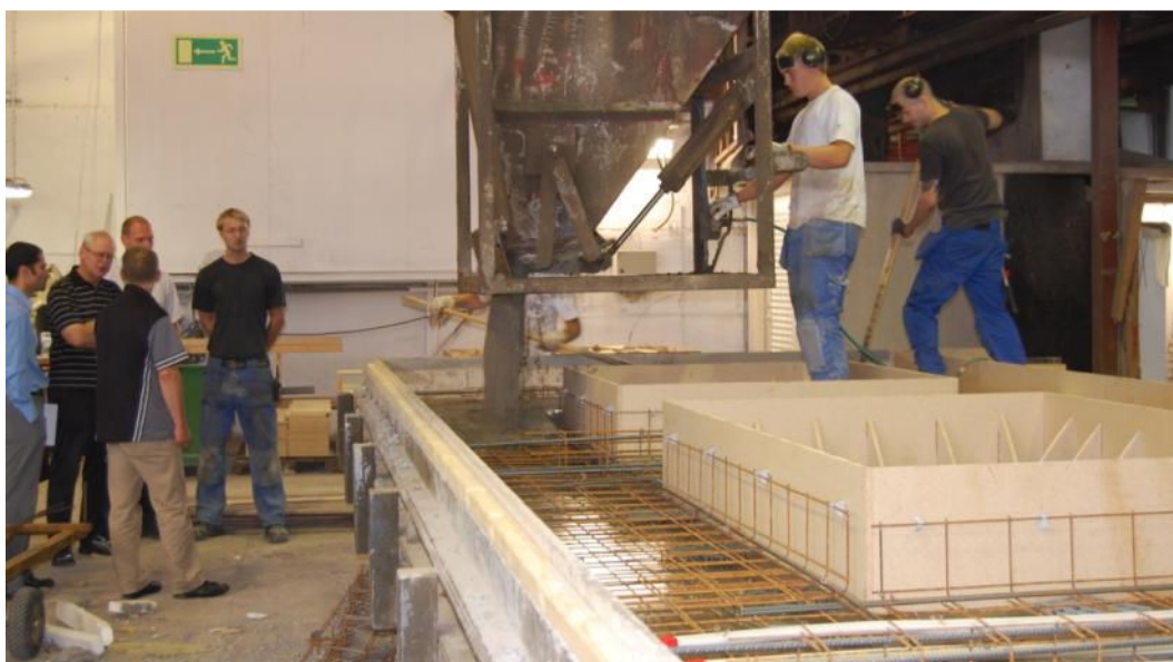
Gjutning av sandwich-väggar under studiebesök i Abetongs fabrik i Falkenberg.
