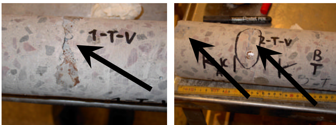
Figur 6.11 Exempel på defekter, vattenseparation och dålig omslutning av armering, som observerats hos utborrade kärnor. De aktuella kärnorna har beteckningar 1 T-V (vänster) samt 2 T-V (höger).
