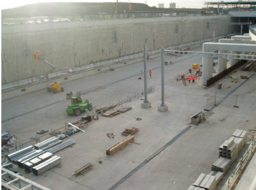
Figur 2.4 Exempel på permanent slitsmur. Utbyggnad av järnvägsförbindelsen mellan London-Paris vid Stratford utanför London. De 17 m höga slitsmurarna fungerar som konsoler.
