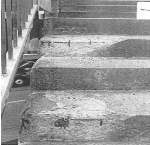
Figure 6. Damaged stairs at Fältöversten, 1998.
