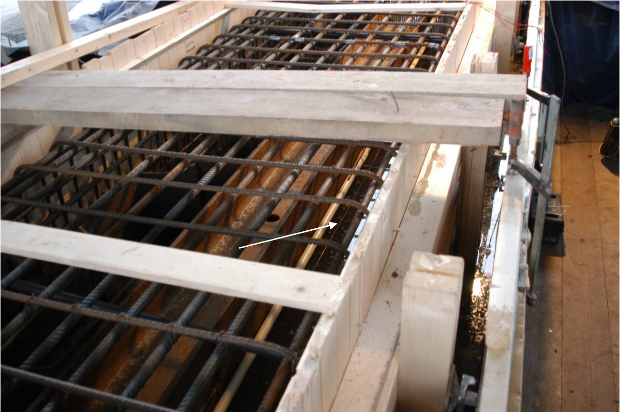
Figur 15: Formsatt fullskalegjutning, observera vattennivå i underkant hammarband.
