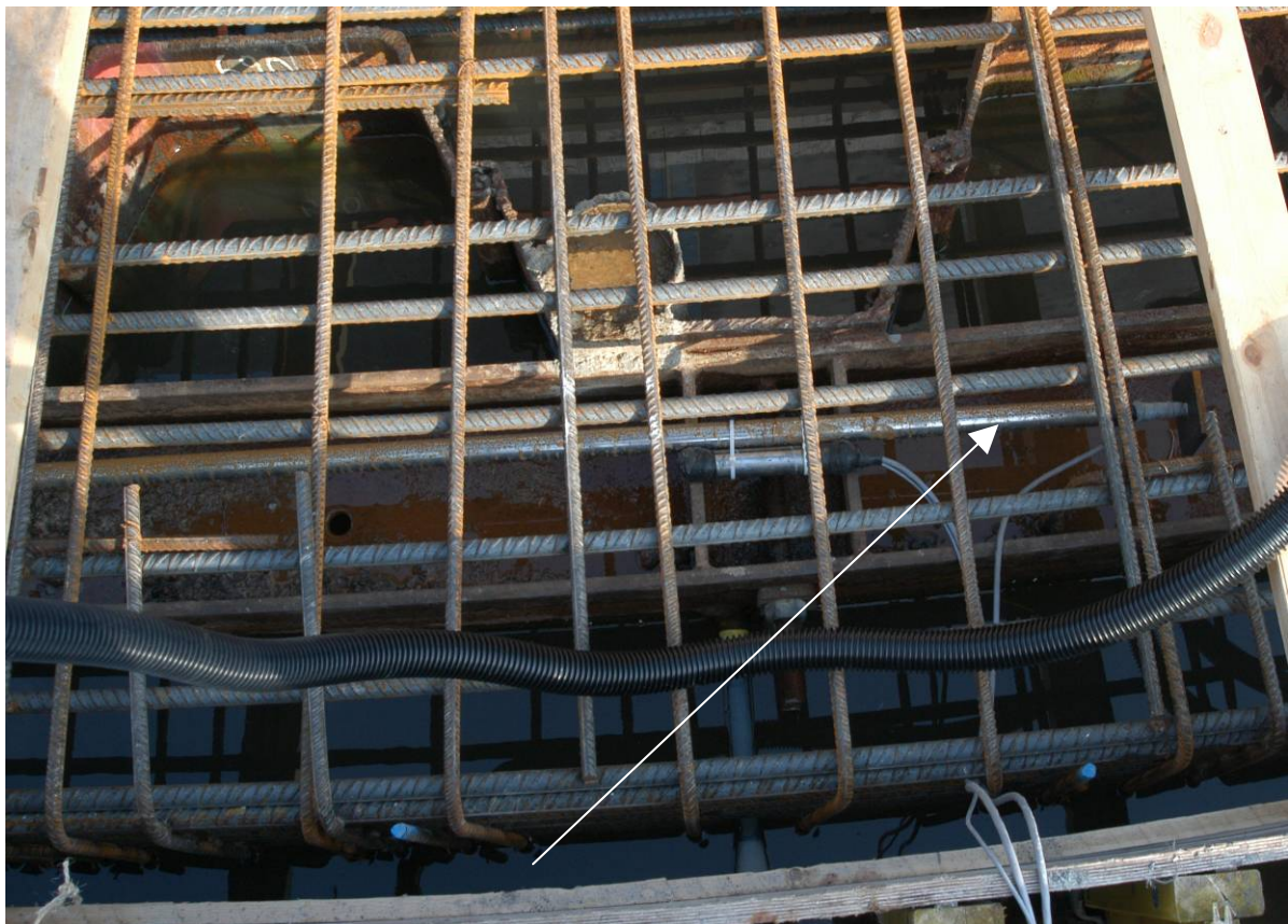
Figur 24: Mätstång med ändförankring i etapp 7 före gjutning.
