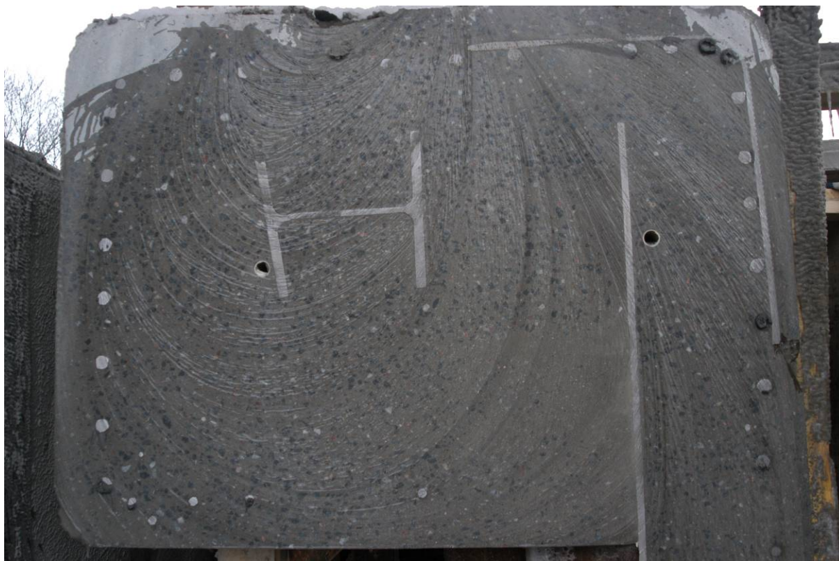
Figur 20: Sågsnittet, alla ståldetaljer var väl omslutna av betong, ingen stenseparation observerades.
