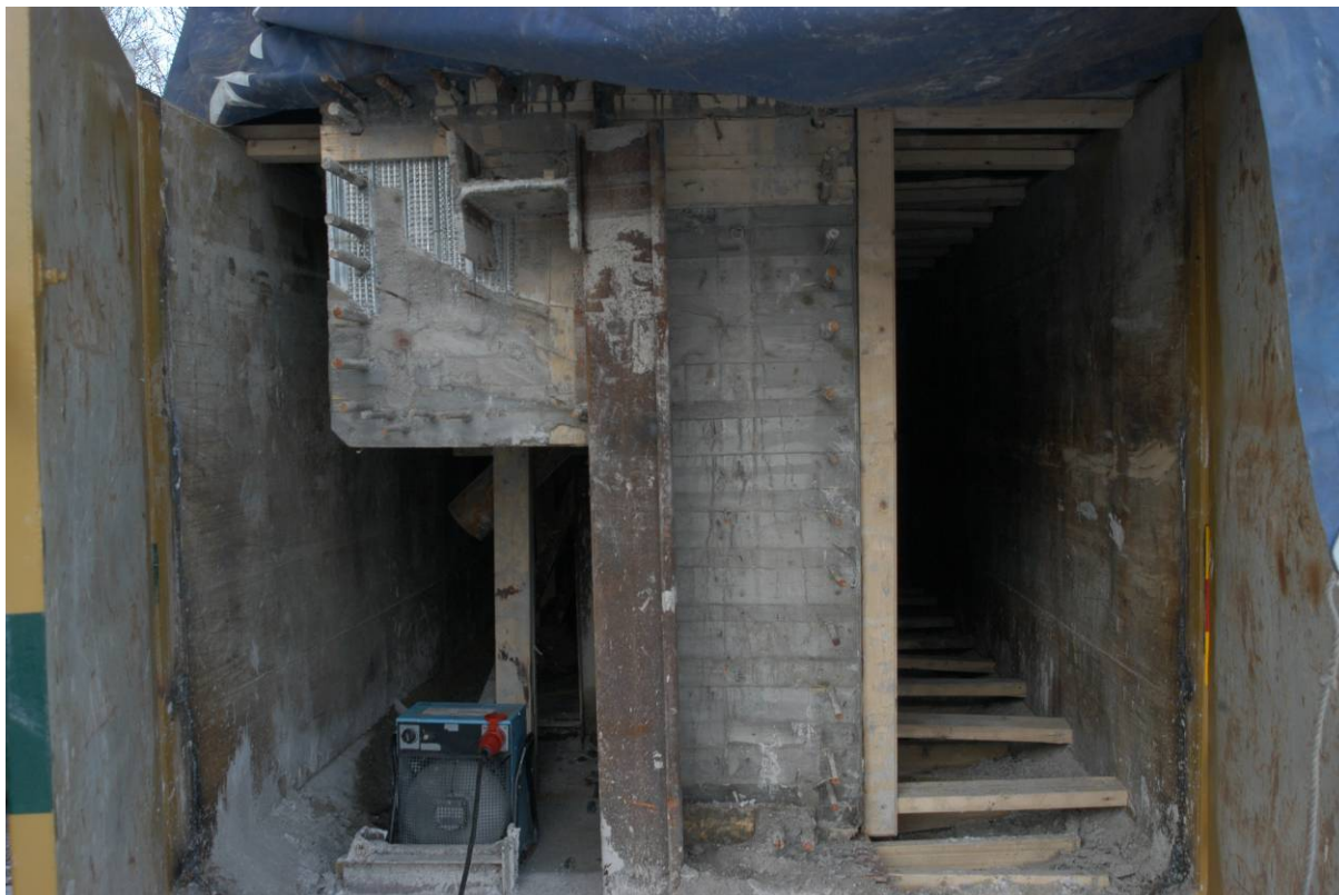
Figur 17: Provgjuten krönbalk efter avformning före sågning.
