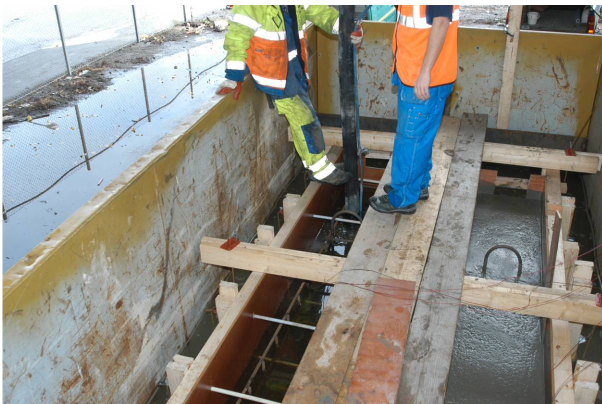
Figur 10: Betongen pumpas bara från en sida, formen är vattenfylld, pumpslangen flyttas inte.
