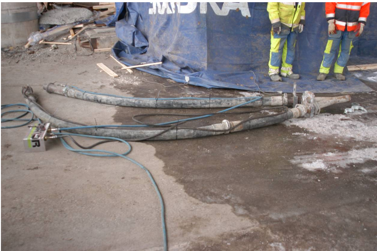
Figur 14: Delad gjutslang med 2 undervattensventiler.
