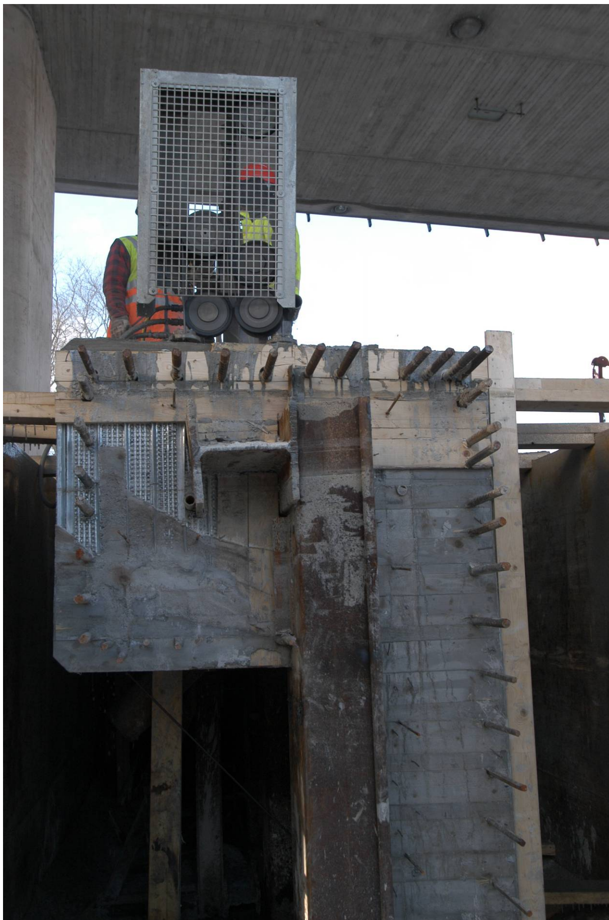
Figur 19: Sågning av provgjutningen, 1 meter från flytsidan.
