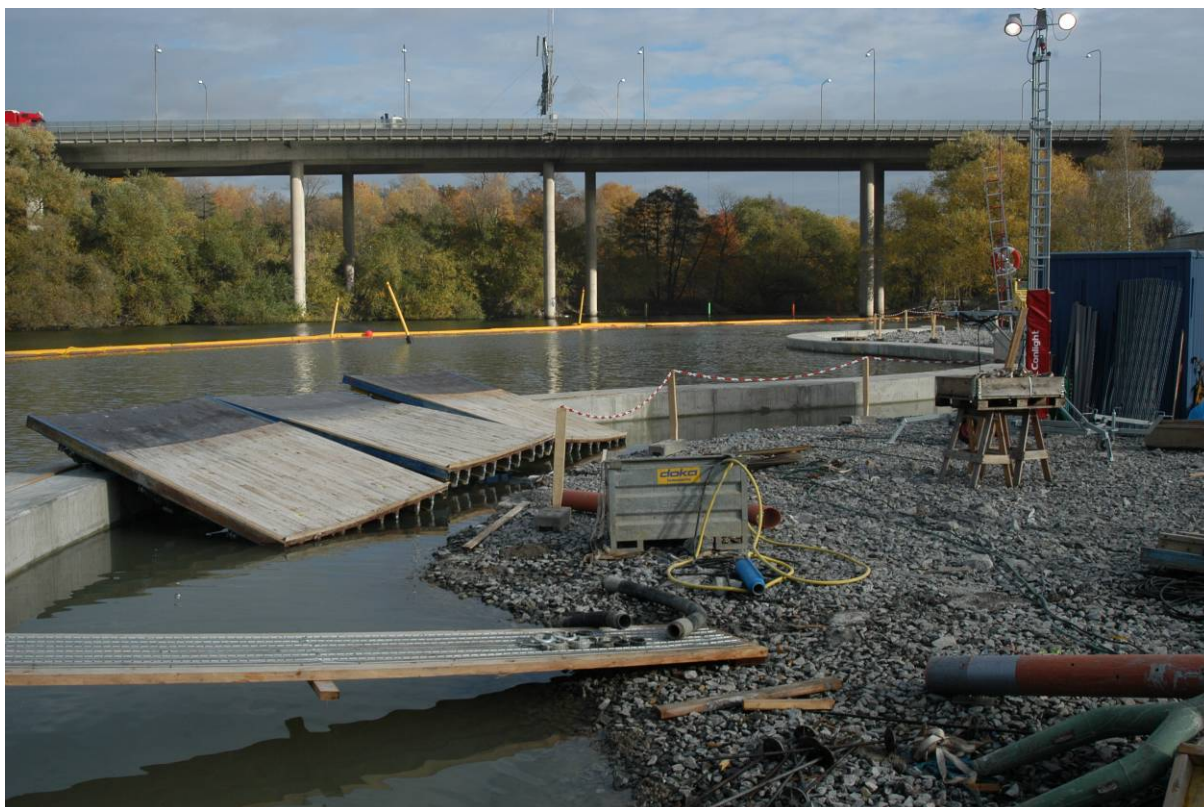
Figur 36: Etapp 1 till 10 är gjutna.
