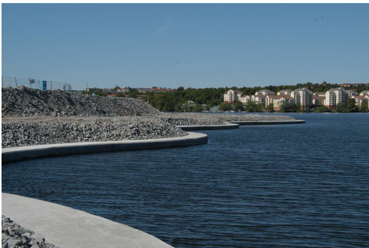
Figur 37: Alla gjutningar avslutade.
