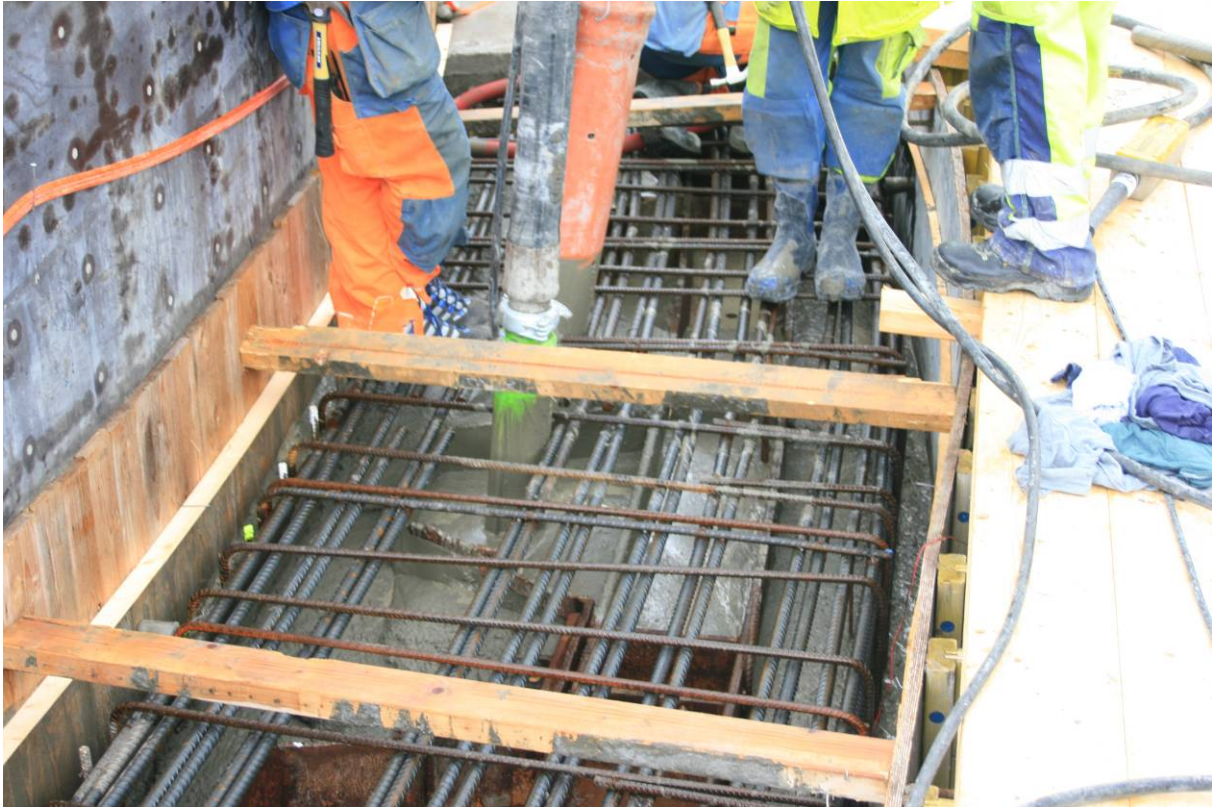
Figur 34: Gjutning med dubbla pumpslangar, en på insidan en på utsidan spont.
