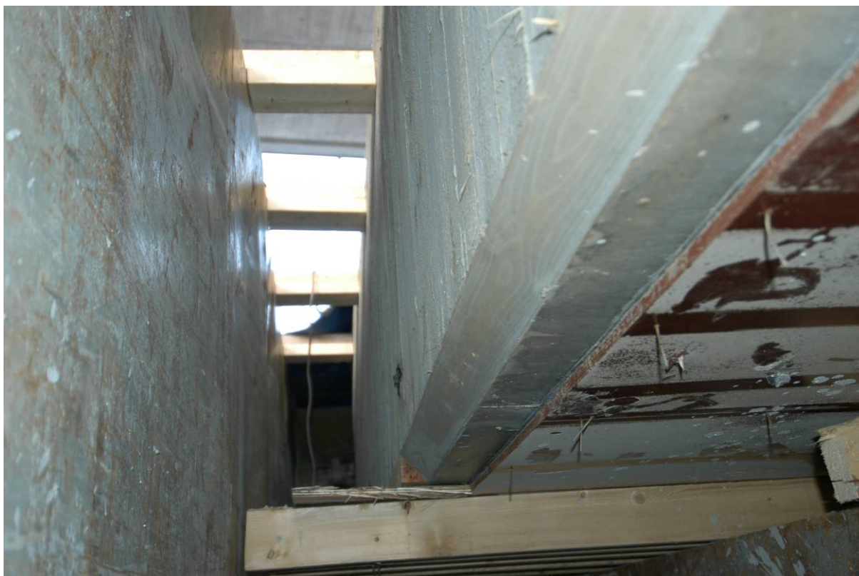
Figur 18: Undersidan av krönbalken med trekantslist i hörnan, mycket bra kvalité av betongytan.
