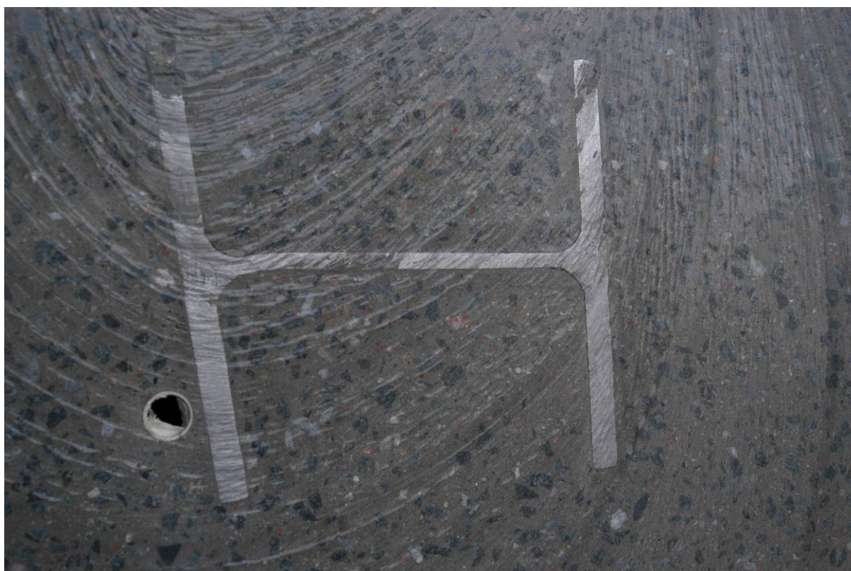
Figur 21: Detaljbild av hammarband och kylrör, komplett omslutna av betong. Inga luftansamlingar eller hålrum upptäcktes. Hammarbandet var deformerat redan före gjutningen.
