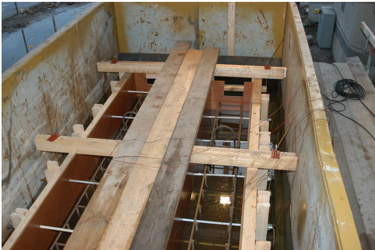
Figur 9: Vattenfylld container med väggformarna.
