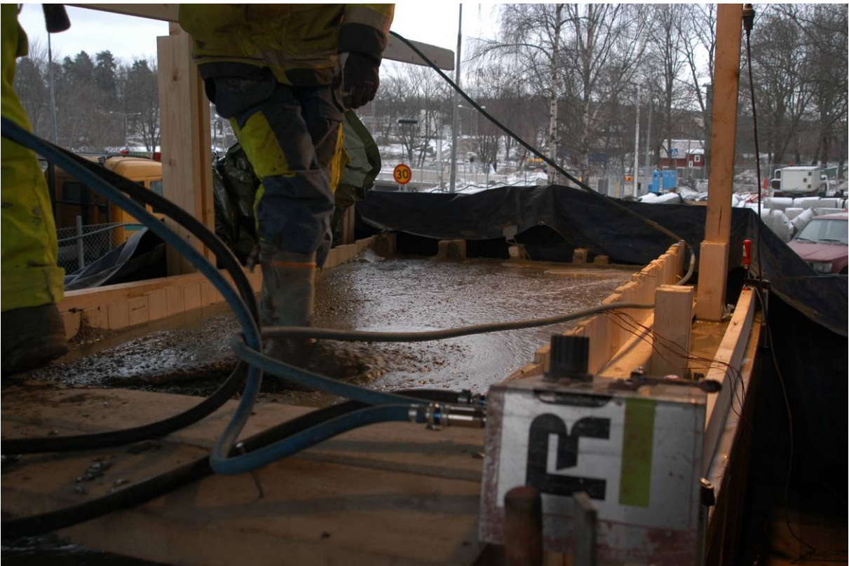
Figur 16: Avslutad provgjutning.
