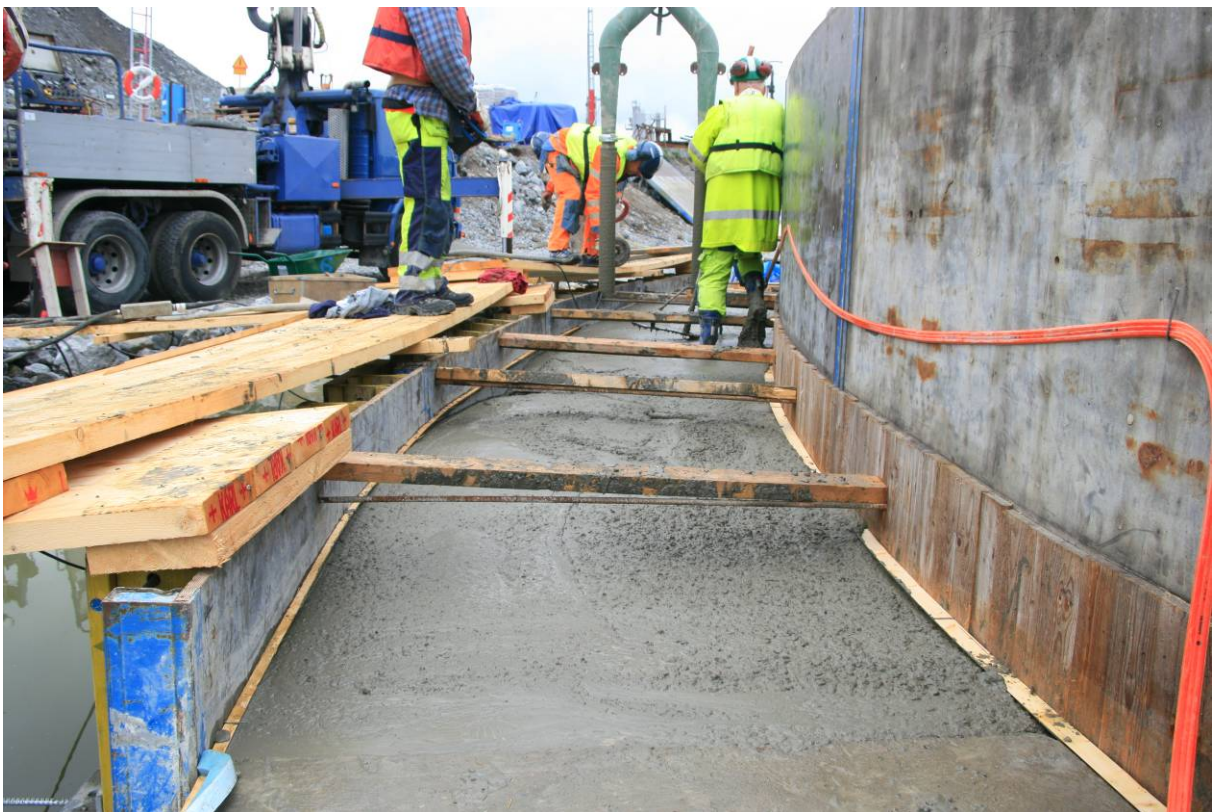
Figur 35: Gjutning avslutad.
