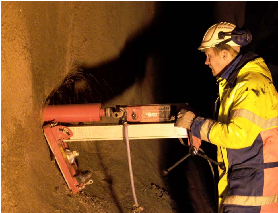
Provboring i den frysta pilotunneln mars 2007
