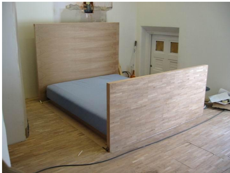
Figur 12. Sängkonstruktion under byggskedet
