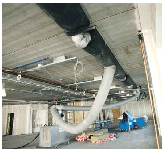
Bild 8.1: Aggregat för högtryckstorkning av HD/F-bjälklag. Varm, torr luft trycks genom dräneringshålen och får blåsa ut via dräneringshålen i andra änden av elementet. Ett mycket snabbt sätt att torka HD/F-plattor.
