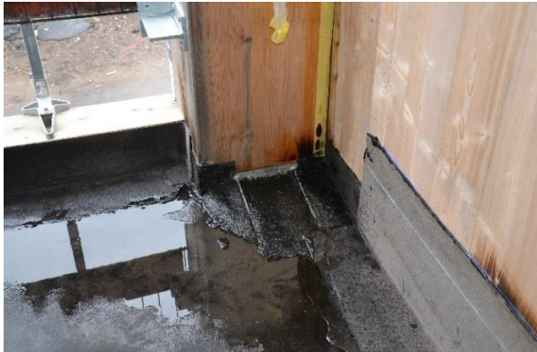
Hörnpelare. Uppvik mot vägg
