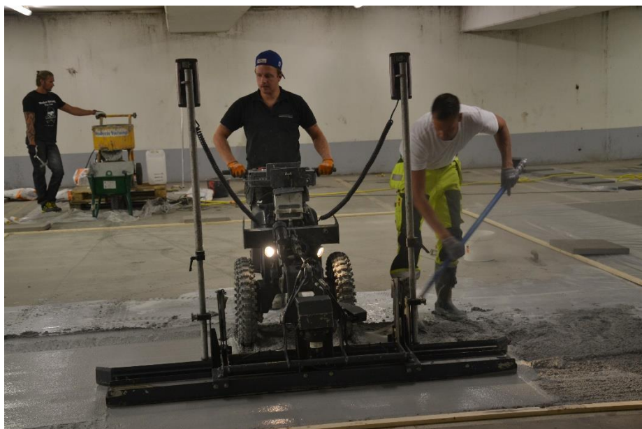
Utläggning av hårdbetong (provläggning på P-däck i betong, Åkeshov 2014)
