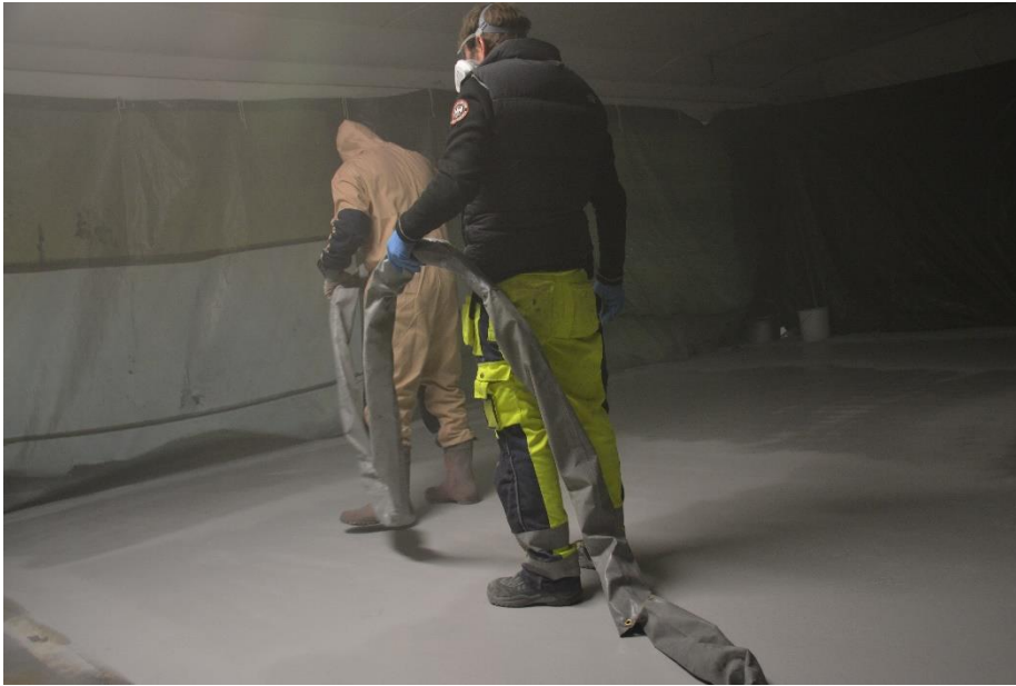
Sprutapplicering av polyurea (provläggning på P-däck i betong, Kville 2013)
