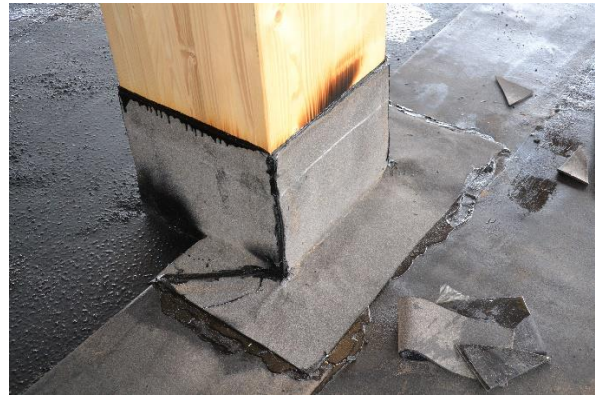
Tätskiktsmatta kring inre pelare. Uppvik mot pelare som också ska förses med skyddsplåt av aluminium
