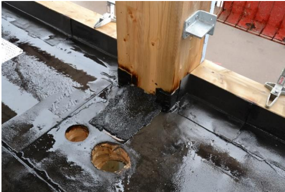
Fasadpelare med uppvik samt genomföringar för någon kommande installation
