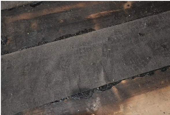
Ramp i närbild med matta över rörelsefog. Beläggningssystem ska påföras
