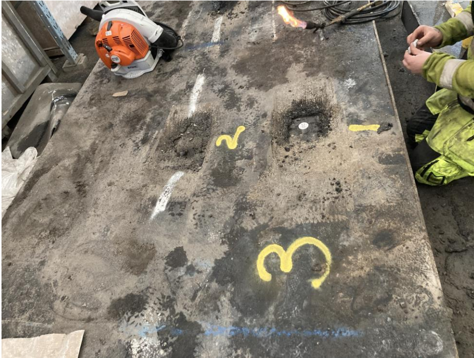
Figur 2 Pågående vidhäftningsundersökning på stor provplatta
