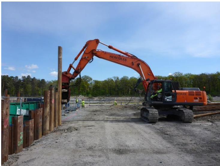
INGRESSBILD. Vid fältförsöket i Västerås 2019 användes en grävmaskinsmonterad vibrator.
