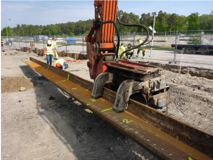
Figur 3. Bilden visar hur den grävmaskinsmonterade vibratorn greppar plankan i livet från sidan med hydrauliska griplor.
