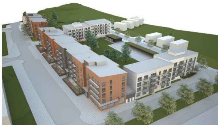
Bild: SKB och NCC bygger i Ursvik
