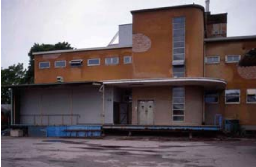
Bild 34: Bageri- och charkuterifabriken i Västerås uppfördes i början av 1930-talet av den lokala konsumtionsföreningen Svea. Det är en funktionalistisk anläggning med tydliga holländska influenser bl.a. i bageriets hiss- och trapptorn. Typiskt för anläggningar som dessa är de taktäckta lastbryggorna. Verksamheten är sedan en tid nedlagd i väntan på beslut om byggnadernas framtid. Foto Lisa Brunnström
