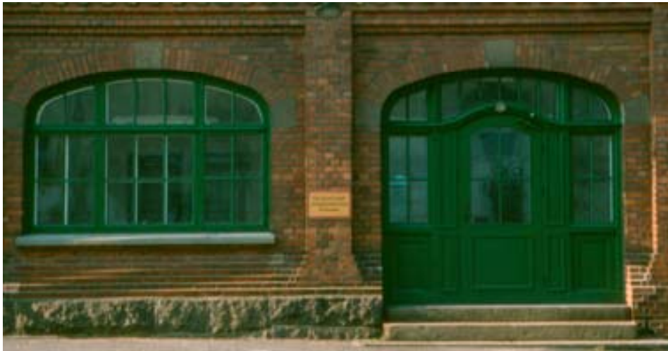
Bild 33: Portar och fönster vid det tidigare Kockums Emaljverk i Ronneby från 1908 har fått behålla jugendinspirerad färg och form trots att byggnaden sedan länge har en ny funktion. Foto BS 1994.
