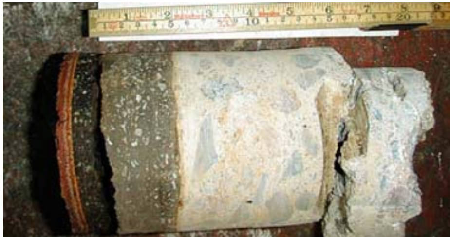
Bild 16: När en hel borrkärna tas ut från ett betongbjälklag kan olika material, färgskiftningar m.m. lättare upptäckas. Nackdelen att borra är att provet kan påverkas genom t.ex. hög temperatur och vattenkyllning.
