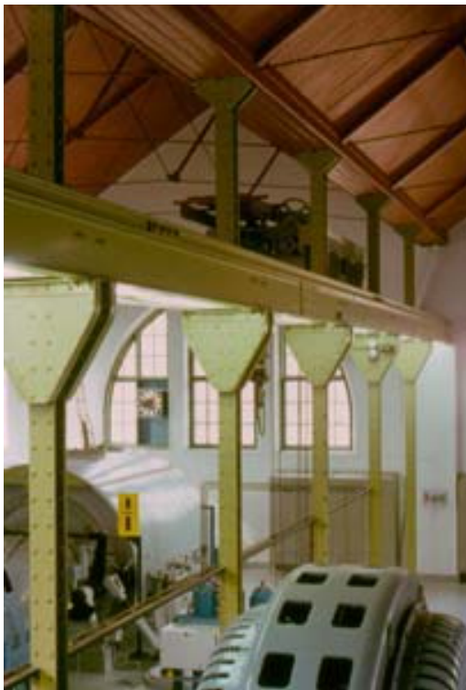
Bild 37: Interiör från Ludvika kraftstation byggd 1900. Byggnaden har inte förändrats nämnvärt under åren och dess nakna och okomplicerade konstruktioner visar tydligt hur tak och traversbana bärs upp. Foto Bengt Spade 1990.
