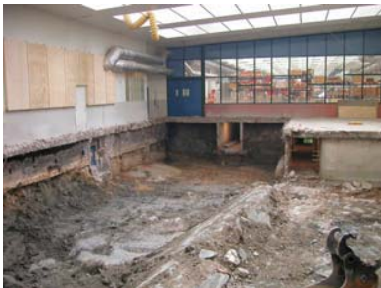
Bild 7: Föroreningar kan finnas i underliggande mark och kan avges till inomhusluften och spridas till grund- och ytvatten.
