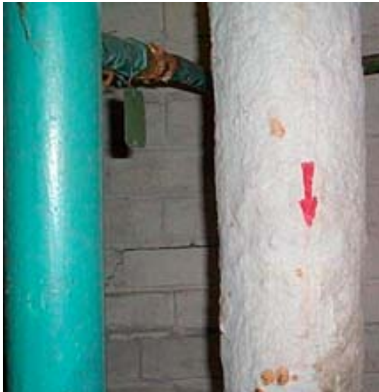
Bild 9: Asbest kan t.ex. finnas i isolering på rör.
