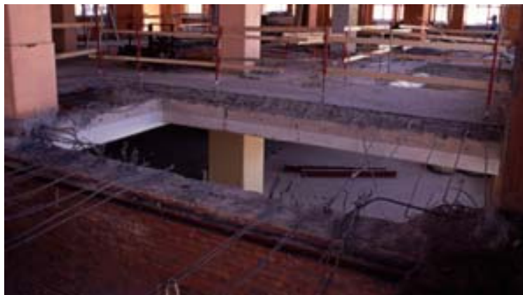
Bild 24: Rivning av bjälklag är ett åtgärdsalternativ.
