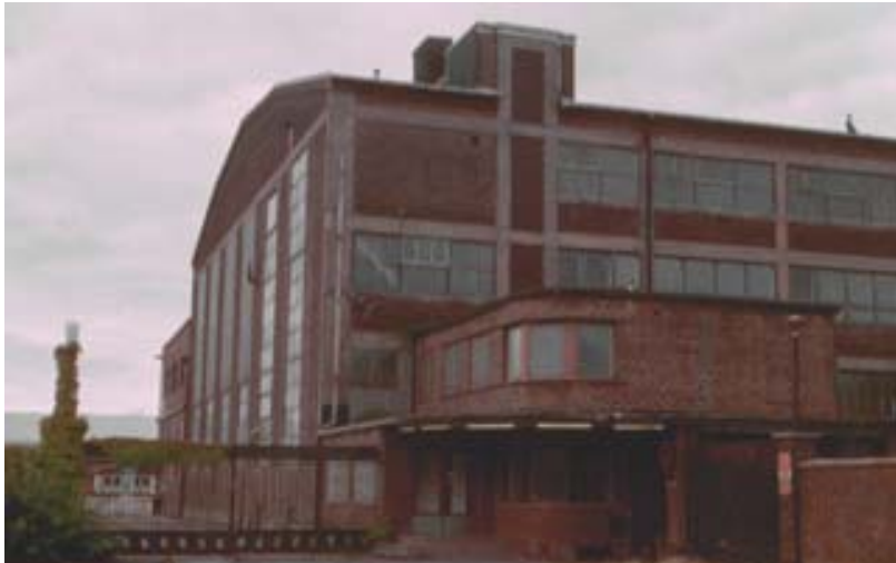
Bild 30: Verkstadsbyggnaden med huvudvaktan vid f.d. Landsverk i Landskrona från 1930-talets början illustrerar en byggnad vars öde ännu inte avgjorts. Långfasaden redovisar tydligt byggnadens pelar- balkkonstruktion med fönsterförsedda utfackningsväggar. De höga gavelfönstren löper genom fasadens hela höjd och skänker, jämte det brutna taket, en monumentalitet åt den breda byggnaden. Andra karaktärsfulla element är hissöverbyggnaden, den rundade, låga utbyggnaden med vaktkuren intill entrén i markplanet och fabriksgrindarna. Foto 1999 B Spade.
