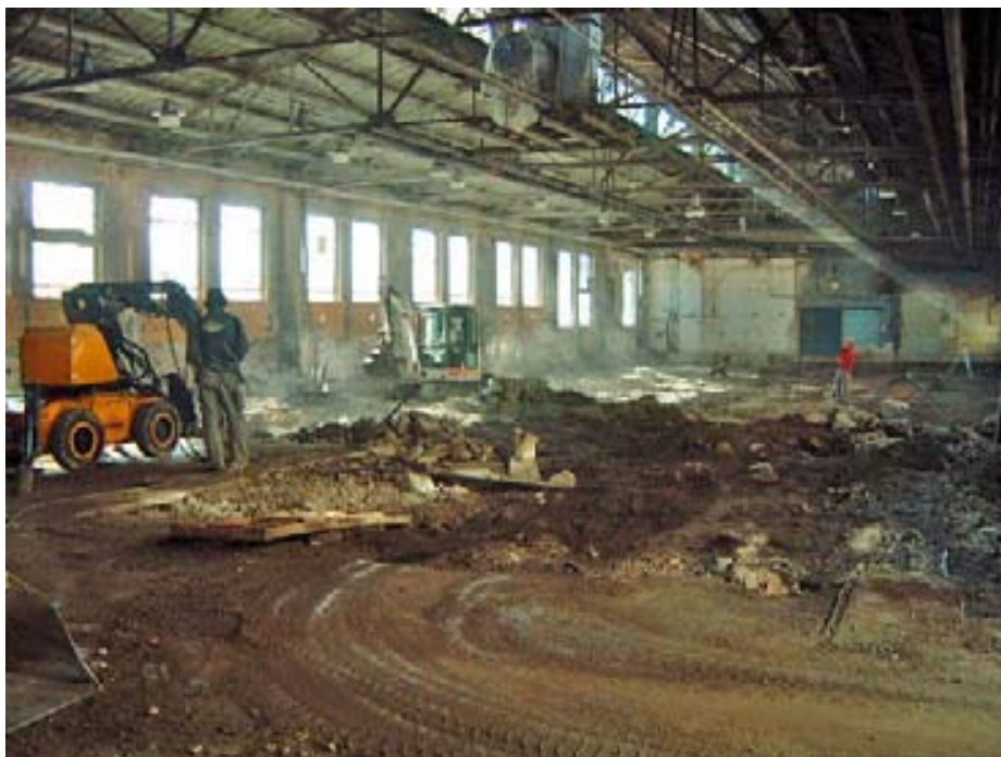
Bild 25: Sanering av underliggande mark kan vara svårt, tidskrävande och kostsam att genomföra. Det är dock mycket viktigt att föroreningar i underliggande mark beaktas och att åtgärder vidtas för att förhindra att föroreningarna når inomhusluft eller sprids till grundvattnet. Upphovsrätt JM.
