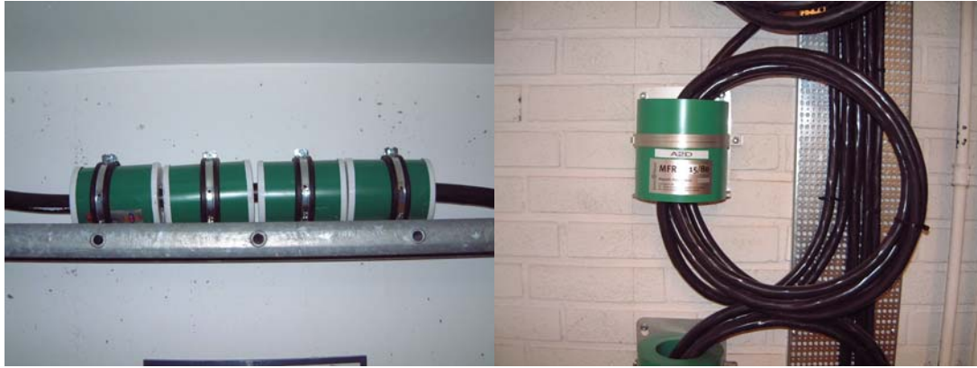
Figur 3.9. a) För att få högre effektivitet kan flera kärnor användas på samma kabel. b) Om kabeltjockleken tillåter flera varv genom kärnan ökar effektiviteten, foto EnviroMentor AB.
