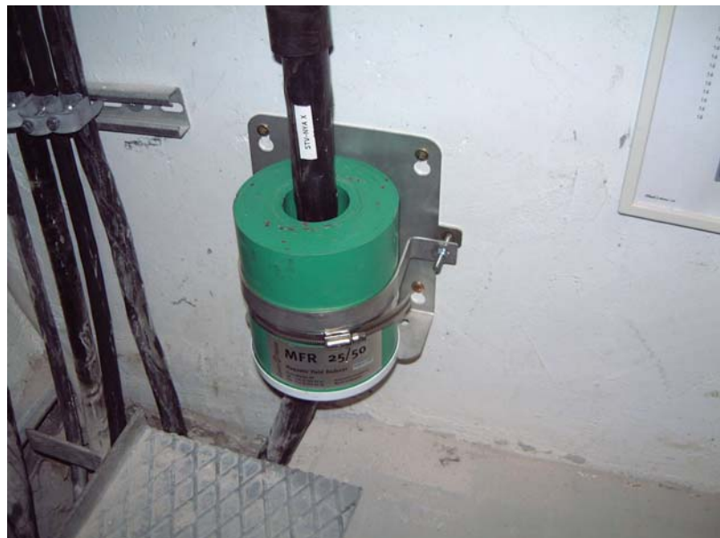
Figur 3.8. En sugtransformator kärna monterad på en serviskabel, denna kärna är öppningsbar och kan därför monteras på kabeln utan att kabeln behöver kopplas ur, foto EnviroMentor AB.
