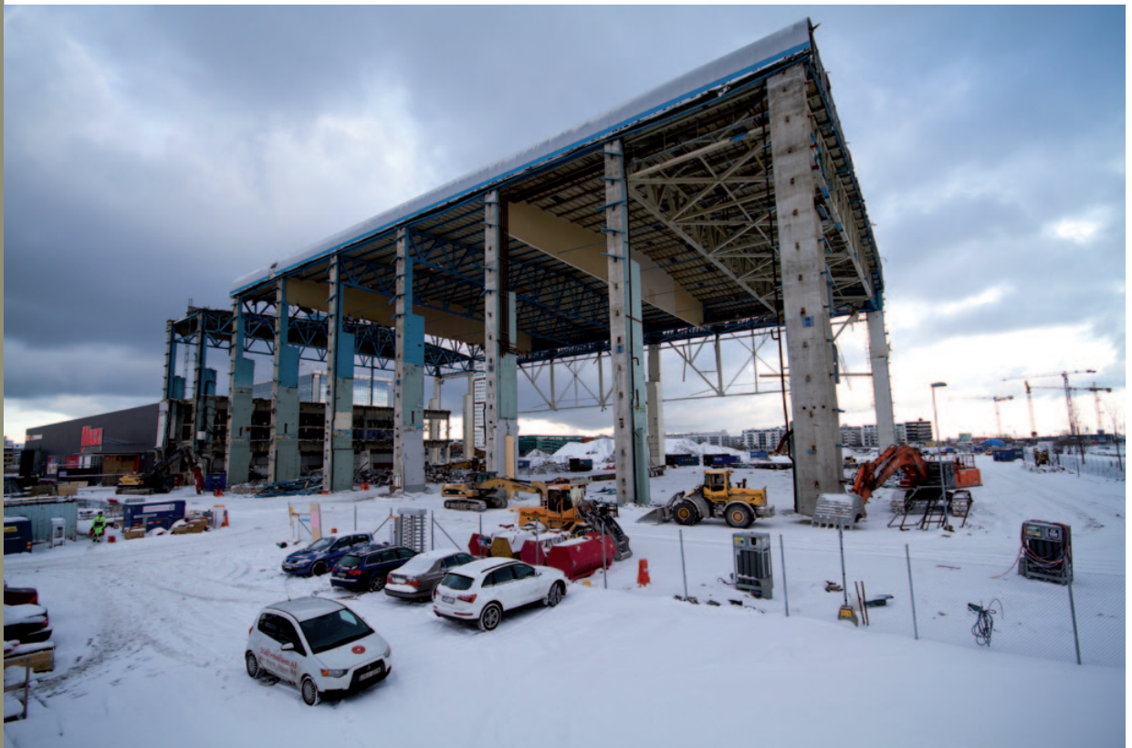
Figur 16. Rivningsbetong återanvändes i Diligentias projekt Masthusen och sparade på så vis en stor mängd lastbilstransporter. Foto: Claes Thureson.
