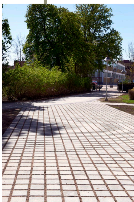
Figur 2. Dränerande markstensbeläggning i Malmö.
