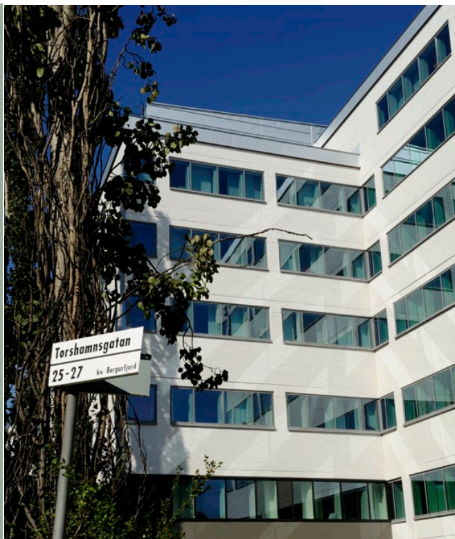
Figur 13. Ericssons kontor efter ombyggnad. Betongstomme och tegelfasad sparades vilket gav poäng enligt LEED. Foto: Pia Öhrling.
