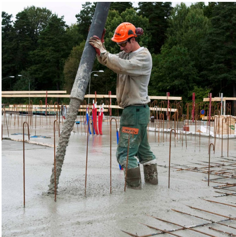
Figur 21. Utan flyttillsatsmedel är det omöjligt att tillverka en självkompakterande betong som bl.a. eliminerar ett tungt arbetsmoment, nämligen vibreringen av betong.
