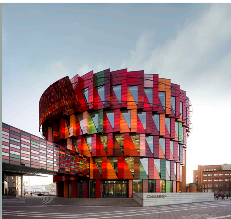
Figur 4. Kuggen, som har en platsgjuten betongstomme, är certifierad enligt både GreenBuilding och Miljöbyggnad nivå Guld. Foto: Tord-Rikard Söderström (Wingårdh Arkitektkontor).
