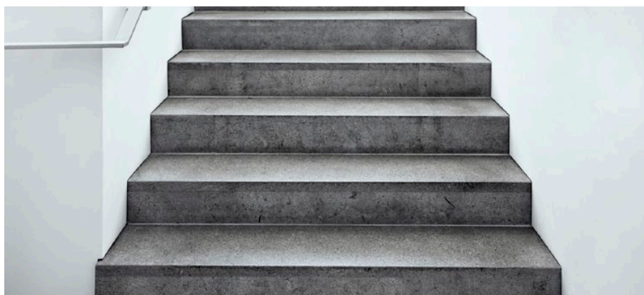
Figur 26. Betong lämpar sig mycket väl för användning i ytor som regelbundet utsätts för stort slitage.
