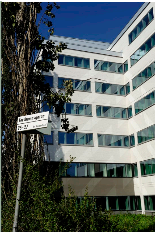
Figur 22. Ericssons kontor efter ombyggnad. Betongstomme och tegelfasad sparades vilket gav poäng enligt LEED. Foto: Pia Öhrling.
