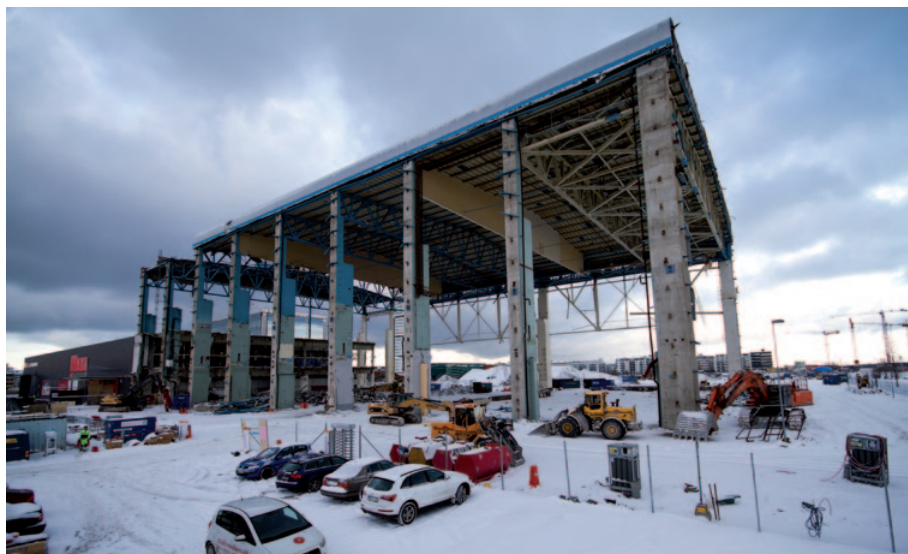
Figur 31. Rivningsbetong återanvändes i Diligentias projekt Masthusen och sparade på så vis en stor mängd lastbilstransporter. Foto: Claes Thureson.
