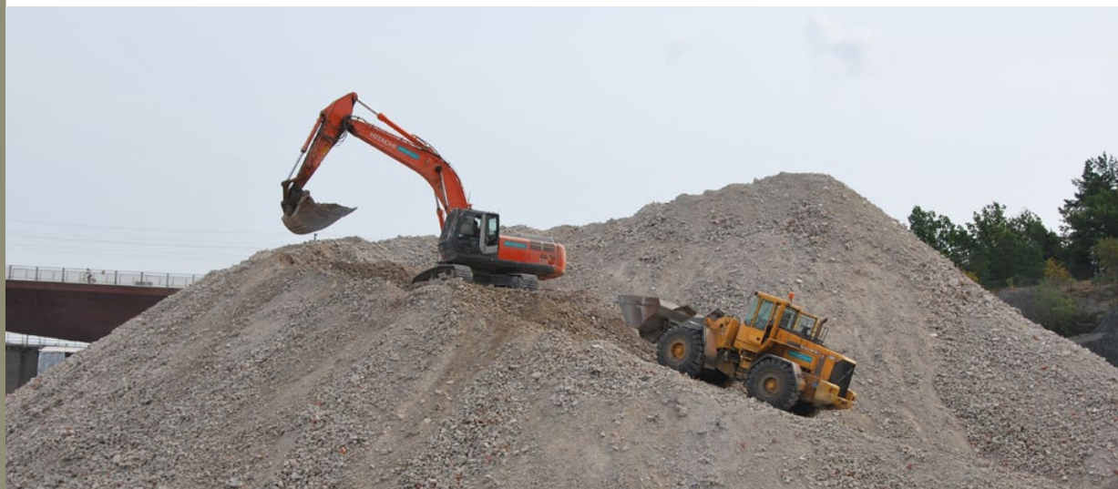
Figur 32. Krossad betong kan användas som ballastmaterial i ny betong. Det vanligaste användningsområdet är dock som fyllnadsmaterial. Bilden visar rivningsbetong vid Liljeholmskajen.
