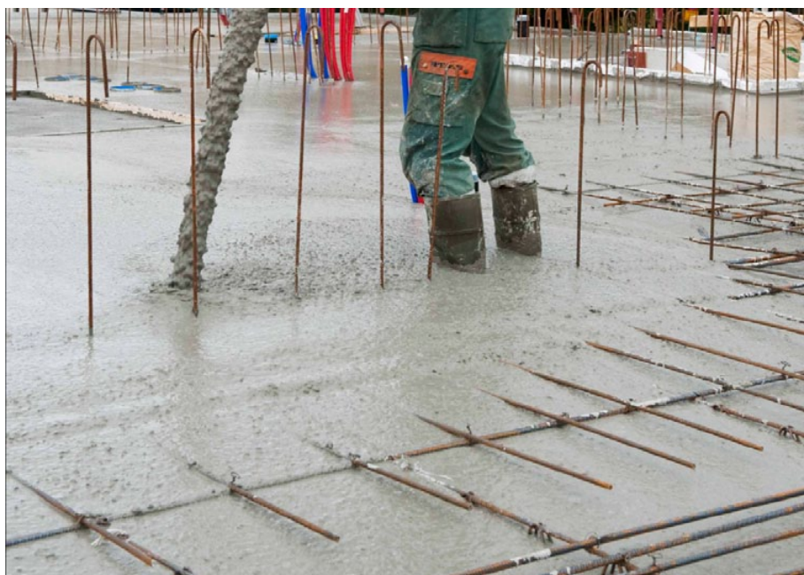
Figur 29. Utan flyttillsatsmedel är det omöjligt att tillverka en självkompakterande betong som bl.a. eliminerar ett tungt arbetsmoment, nämligen vibreringen av betong.
