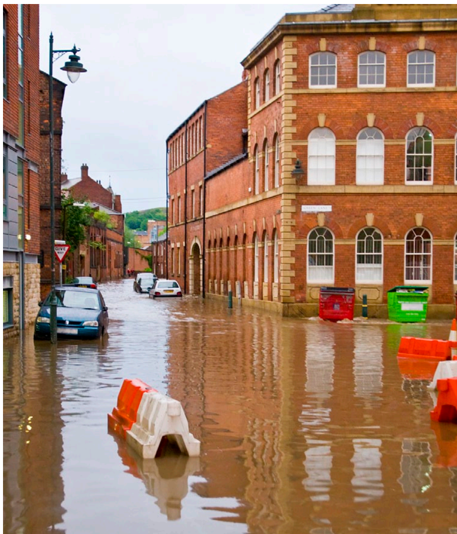
Figur 34. Översvämningar är idag ett stort problem, inte minst i städer med många hårdgjorda ytor. Översvämningar och dess följdverkningar förväntas bli ett allt större problem i framtiden.
