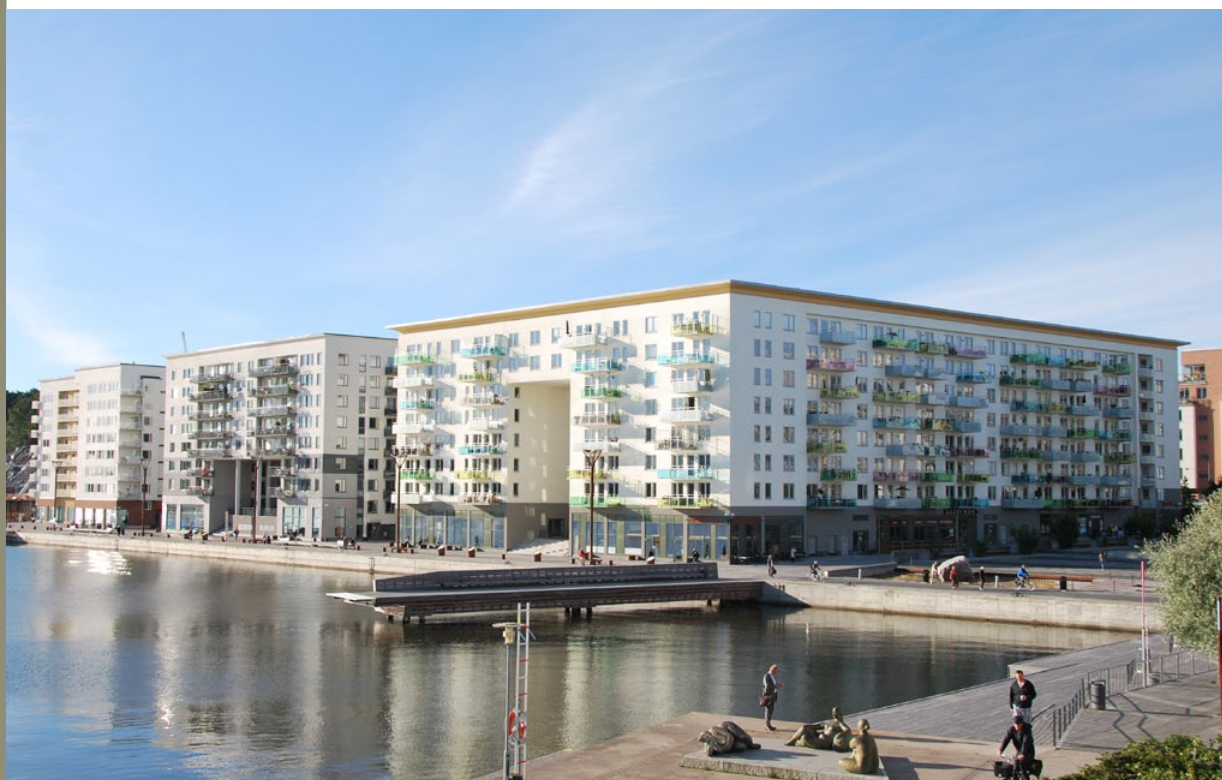
Figur 33. Över hundra ton betong återanvändes då gamla fabriker revs till förmån för nya bostäder vid Liljeholmskajen.
