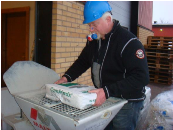
Bild 5. Upphovsmannen knäcker säck med flytspackel
