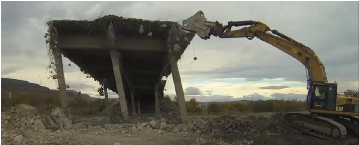
Figur 4.2. Rivning av Gruvbron i Kiruna efter försvagning av infästningar och knutpunkter. Nilimaa et al (2020).
