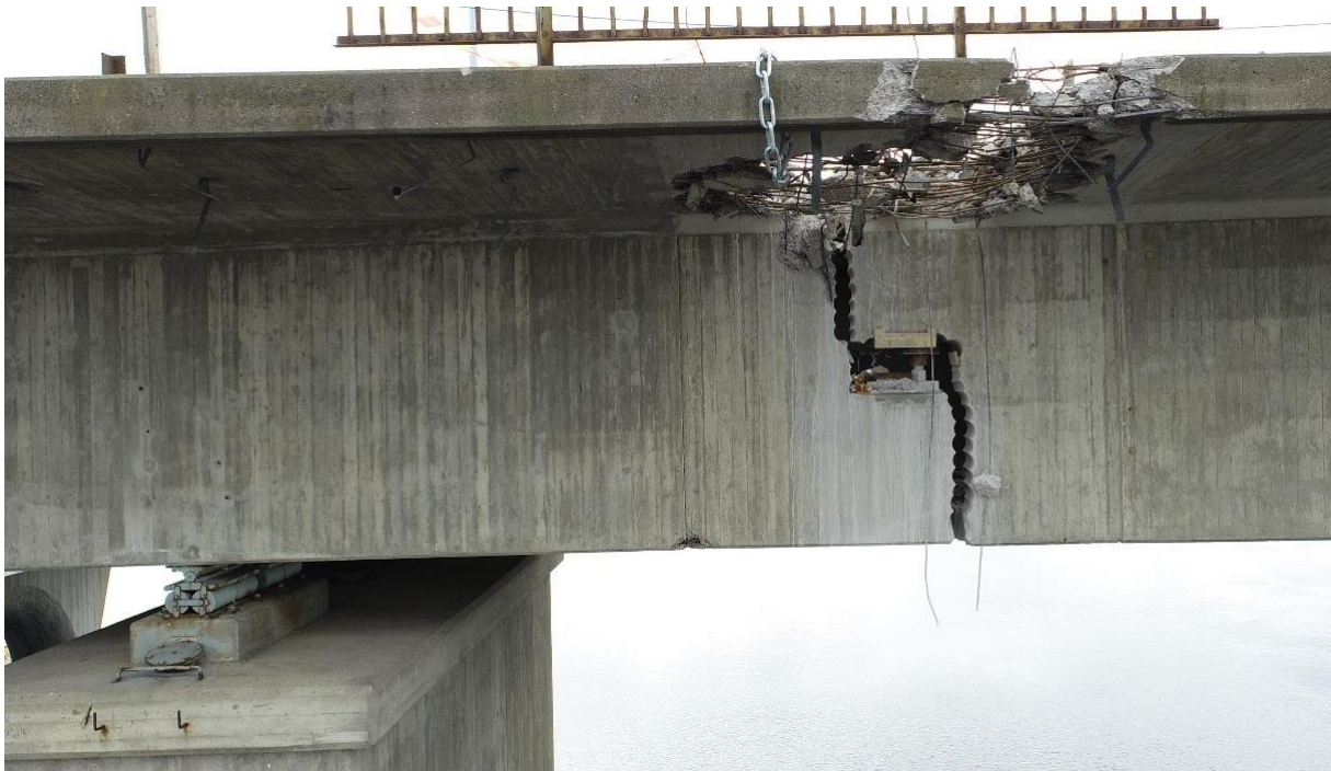
Figur 8.2. Delning av bron vid ändpelaren på Kalix-sidan.
