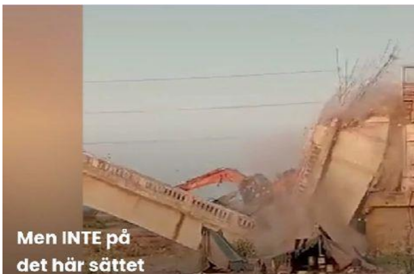
Figur 4.5. Rivning av 70 år gammal fritt frambygd konsolbro i nordvästra Indien, december 2022. Grävmaskinföraren klarade sig med blotta förskräckelsen.
