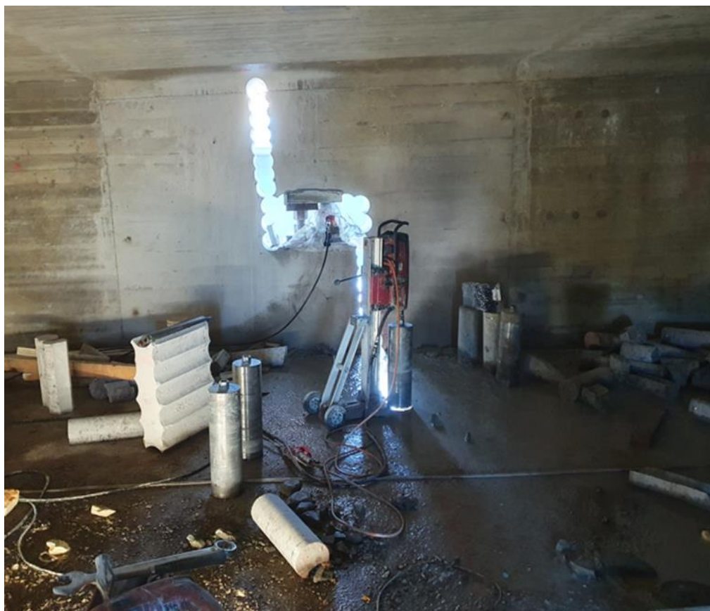
Figur 8.1 Ritning och foto av förfarande vid skiljande av konsolände från ytterspann. Lådtvärsnittets väggar sömborras, en domkraft installeras varefter även bottenplatta och farbana delas. All last koncentreras härvid till domkraften vilken successivt spänns av. Konsolspannet blir därmed losskopplat från ytterspannet.
