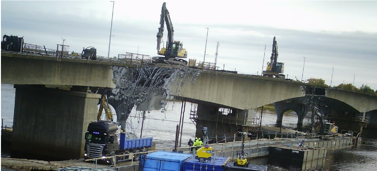
Figur 8.4. Två grävmaskiner tuggar i sig de bågge konsolspannen på båda sidor om mittpelaren mot Kalix-sidan.
