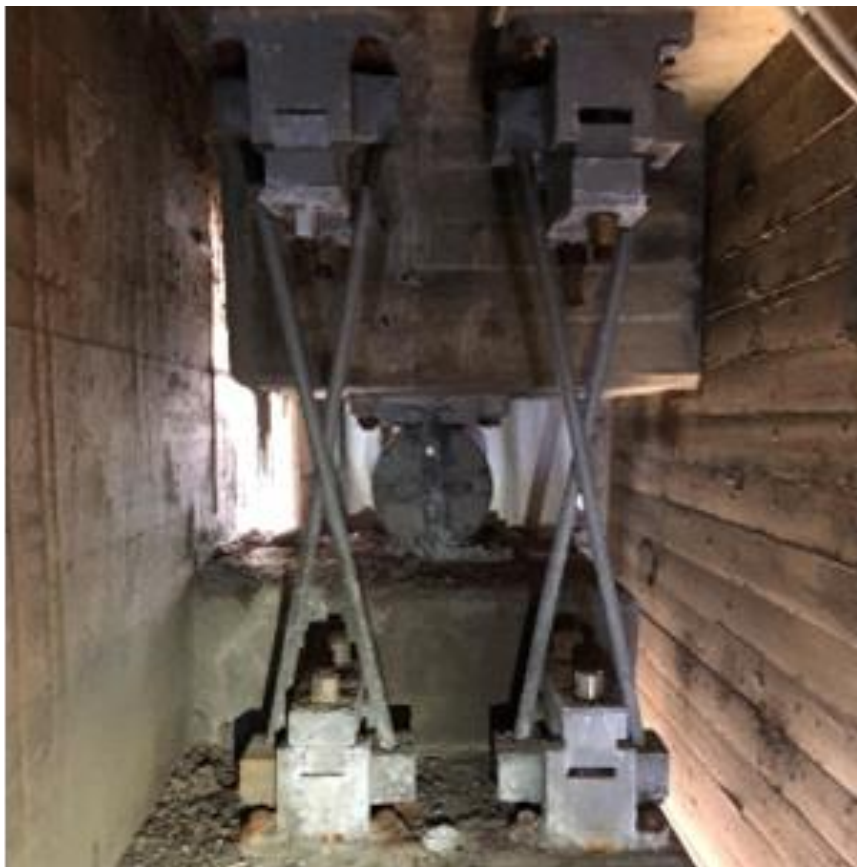
Figur 6.4. Pendellager i brons mittsnitt. Ritning 19.323/91 och foto
