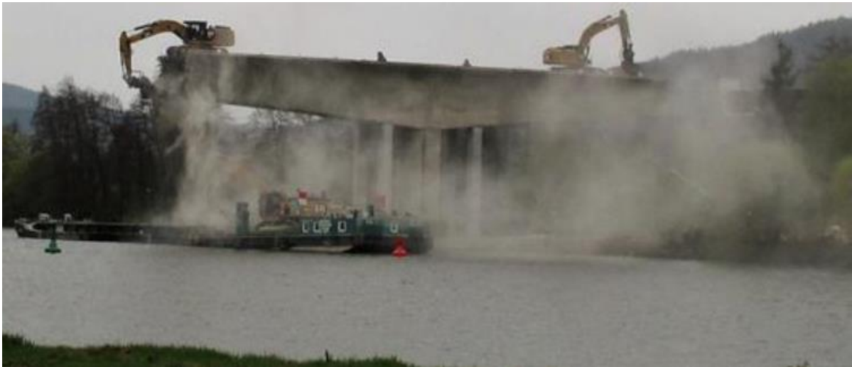
Figur 4.1 Demontering med grävmaskiner som tuggar sönder betongen. Bro över Main vid Gemünden (B27), spännvidd 110 m, Wagner (2017).
