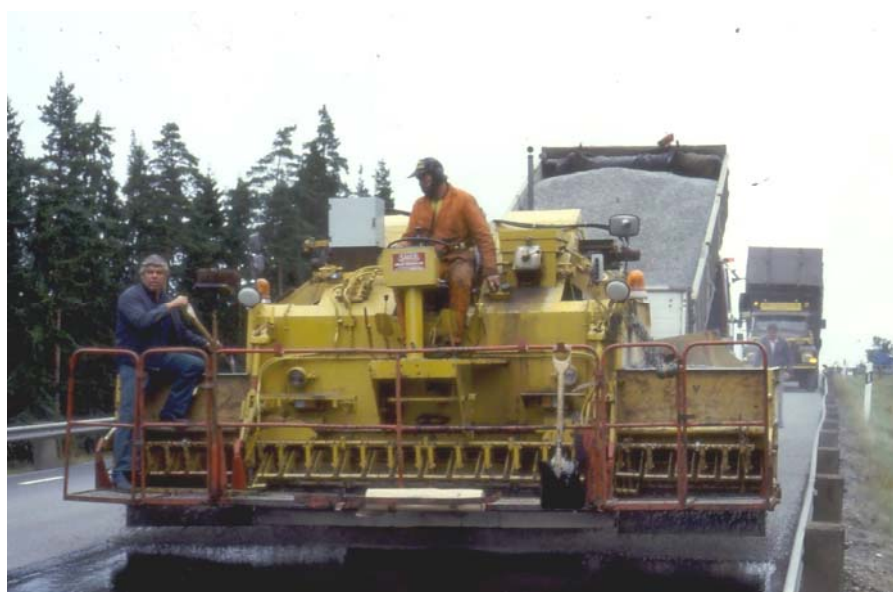
Bild 26. Sidledsfördelningen av stenmaterlalet i pågrus-spridarens breddökningar kunde fungera bättre. Ibland måste en man avdelas för att göra detta för hand.
