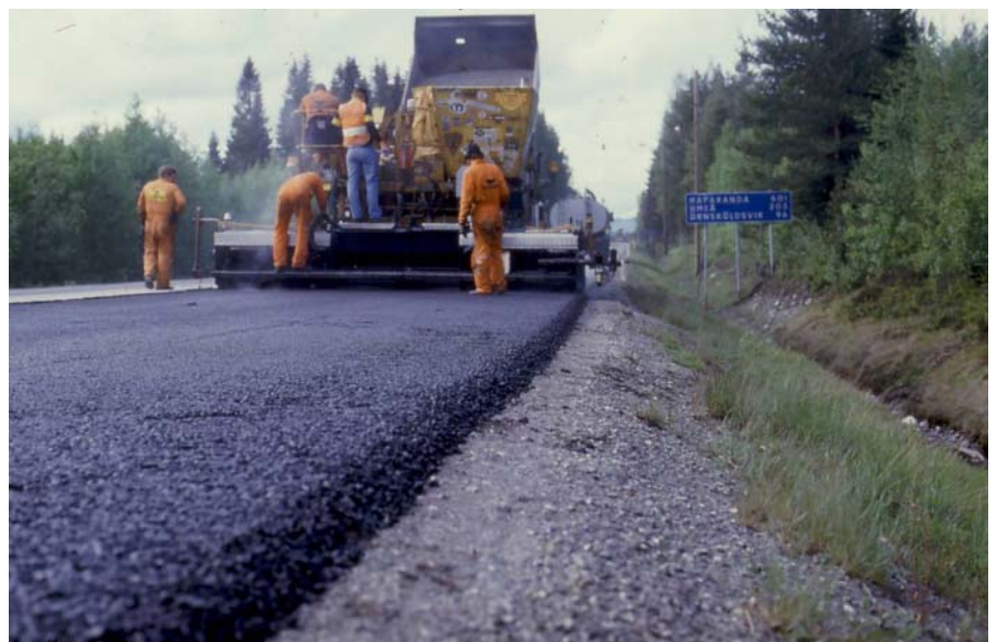
Bild 11. Emissionerna från kall asfalemulsionsbetong AEB O, inskränker sig till avrinning av emulsionsvattnet.
