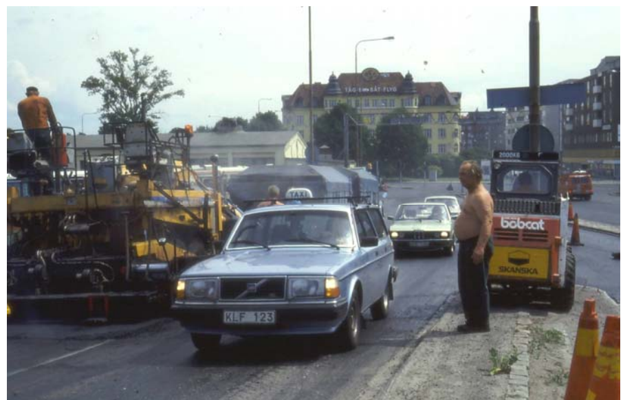
Bild 2. Trafiken är inte bara en fara för personalen utan också ett stort hinder i beläggningsarbetet.
