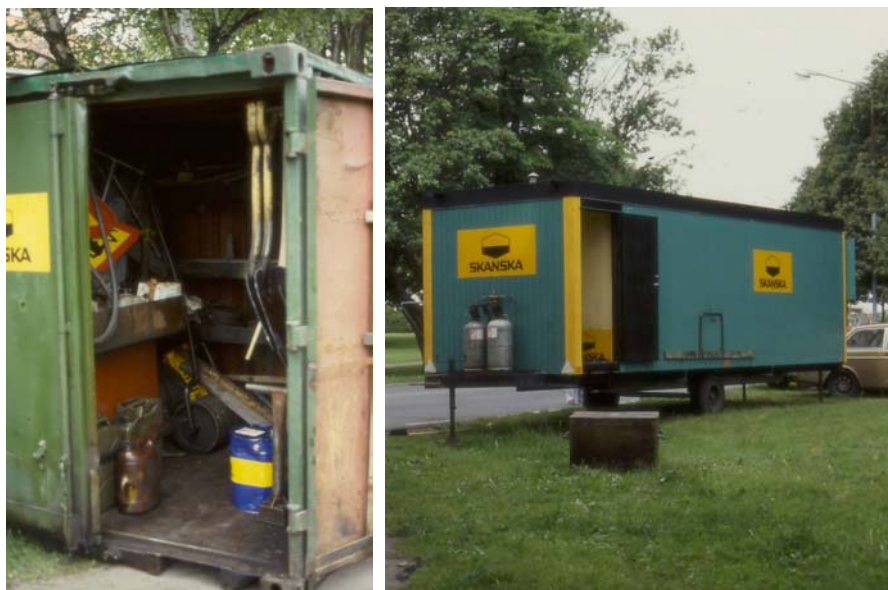
Bild 30. Utrymmena i moderna manskapsbodar och containers är inte överdrivet rymliga. Trots detta är de väl utrustade för personalens alla behov, för materielns förvaring och ger möjlighet till smärre reparationer av redskap och maskiner. Problemen ligger i att finna bra uppställningsplatser och skydda slg mot överkan och tillgrepp.
