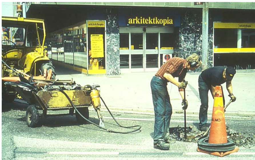
Bild 33. Justering av ventiler och brunnar tillhör de tyngsta arbetsuppgifterna på ett beläggningsarbete. Gamla kragar och dexlar bör långsiktigt kompletteras med justerbara tillbehör eller helt bytas ut mot teleskopiska konstruktioner.
