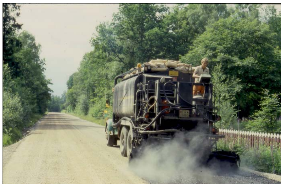
Bild 13. Vid tankbeläggningar utsätts rampoperatören för lösningsmedelsångor från bitumenlösningar. Bitumenemulsioner avger vattenånga.
