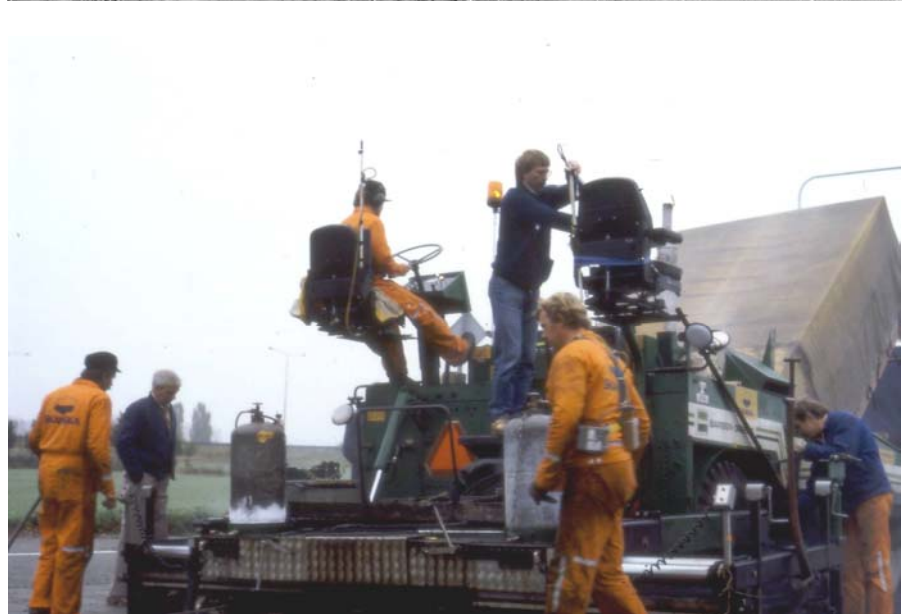
Bild 10. Bygghälsans skyddsingenjörer gjorde omfattande mätningar och analyser av ångorna från återvunnen varmblandad asfaltbetong.
