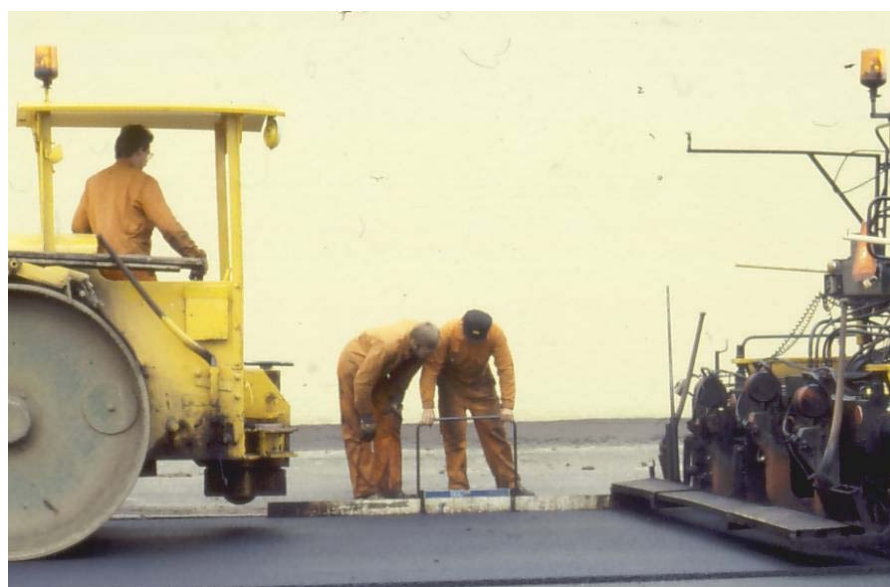
Bild 22. Den lågt placerade förarplatsen på gamla slätvältar bjuder på många fördelar. Uppsikten mot resten av läggjarlaget är god, vilket främjar säkerheten för den oskyddade personalen och underlättar kommunikationen. På- och avstigning sker utan större besvär.
