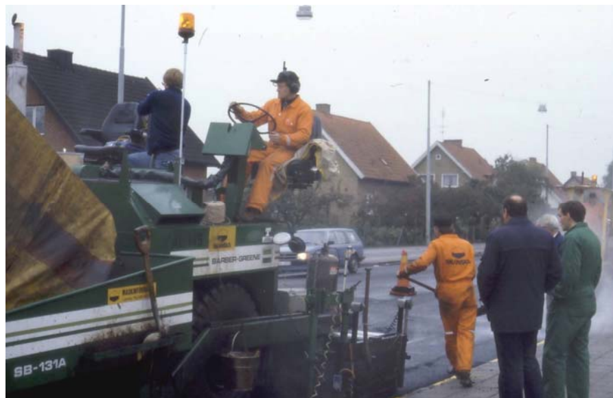
Bild 17. På BARBER GREEN är föraren placerad på en konsolkonstruktion, som ger honom bra överblick av maskinens bakre del. Men han blir samtidigt låst vid förarstolen.
