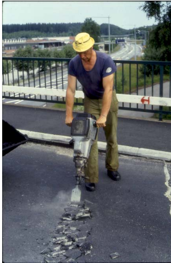
Bild 31. Den bensindrivna asfaltmejseln är ett tungt och vibrerande redskap, som kräver sin man i hanteringen.
