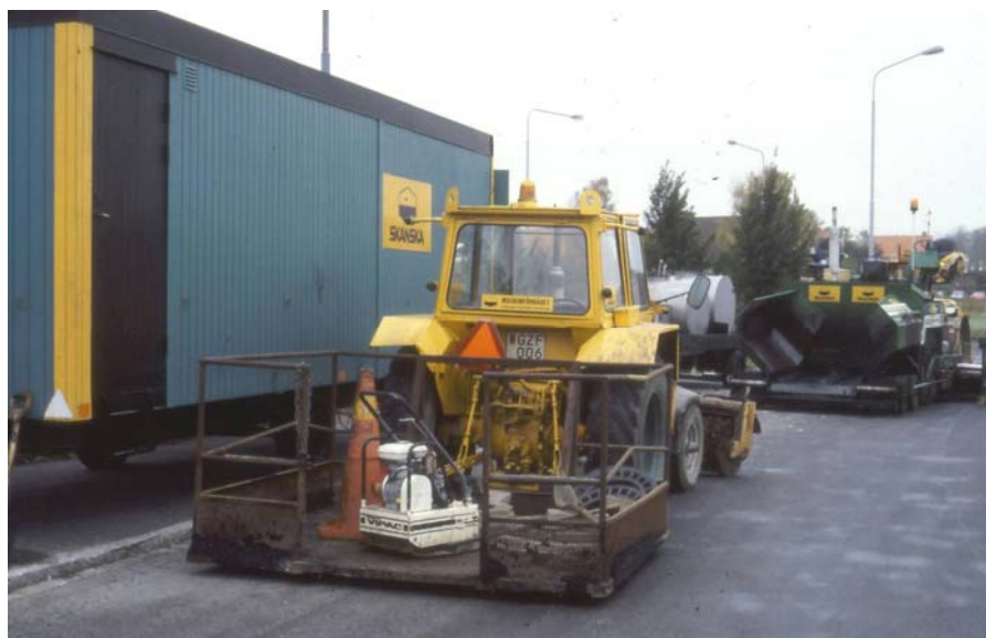
Bild 27. De interna transporterna sköts mycket individuellt. Här har man monterat ett kringgärdat plan på en traktor för transport av klistermoped och allehanda redskap.
