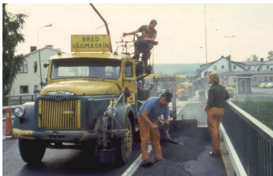
Bild 35. Flera entreprenörföretag konstruerar egna hjälpmaskiner. Här ses Skanskas trottoarläggare.
