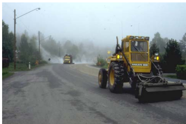
Bild 24. Vid sopningen före ytbehandlingar besväras dammet både föraren och omgivningen. Vanligen bevattnas borsten genom dysor. Den effektiva dammbindningen åstadkommes om ytan vattnas i förväg.
