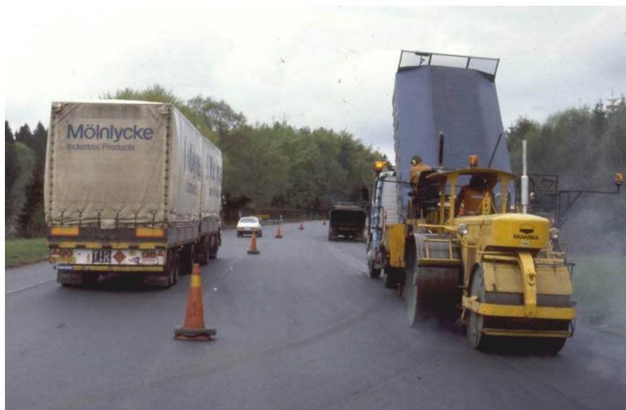
Bild 4. En buffertzona mellan arbetsstället och trafiken skapar trygghet för personalen och ökar effektiviteten i utläggningsarbetet.
