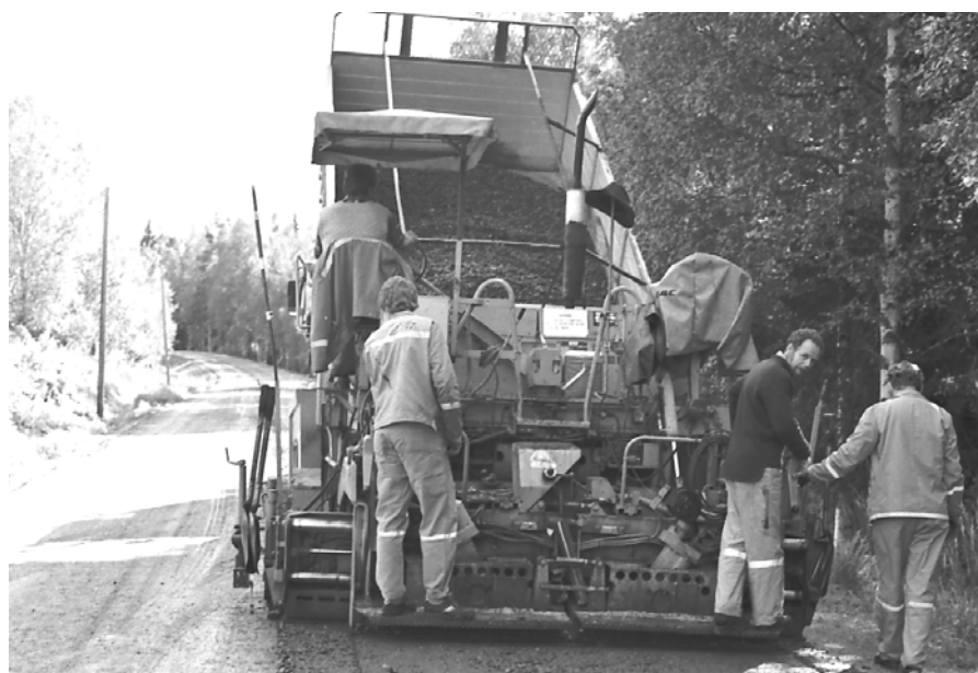
Bild 19. Ett solskydd bör vara så litet som möjligt för att inte fånga upp ångorna och för att inte orsaka drag.
