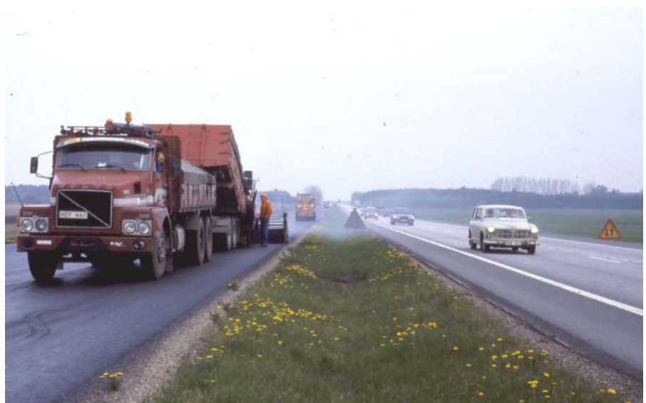
Bild 3. Det blir allt vanligare att trafiken leds dubbelriktad förbi arbetsplatsen på motvägens motsatta sida. Arbetet kan ske utan störningar, med hög kapacitet och med ett gott resultat.
