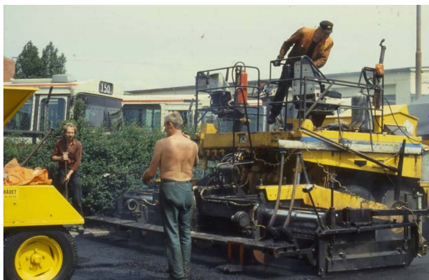
Bild 16. På DEMAGs asfaltläggare finns en slät och kringgårdad yta som tillåter föraren att röra sig fritt under körningen. Med fjärrkontroll skulle han kunna inta den bästa positionen för varje situation.
