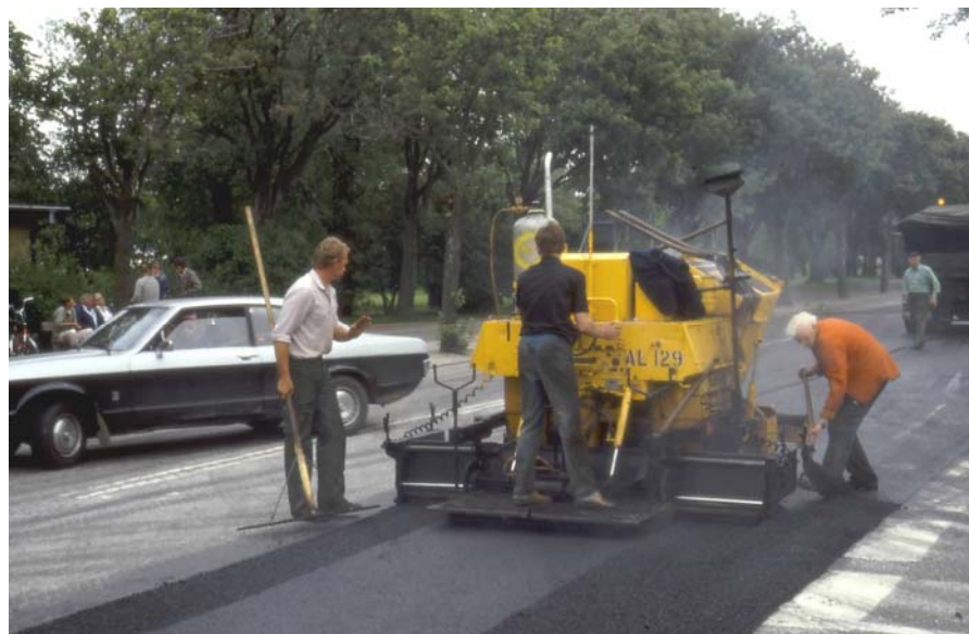
Bild 34. Små asfaltläggare kommer alltmer till användning vid smärre läggningsarbeten. Resultatet är tekniskt vida överlägset det man åstadkommer med handläggning, förutom en stor arbetsbesparing.
