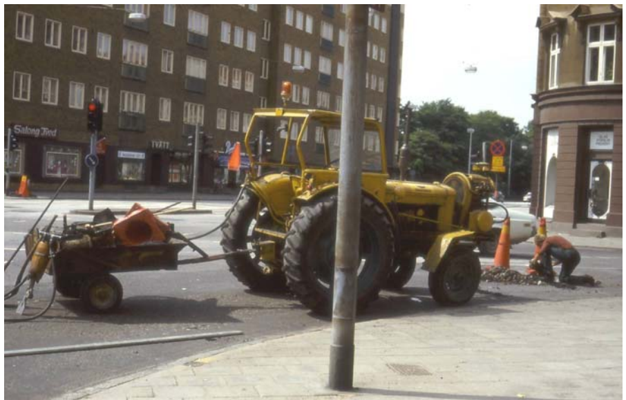
Bild 32. Asfaltmejseln kan också drivas med tryckluft men blir inte lättare av det. Dessutom får man brottas med luftslangarna. En hydrauldriven mejsel blir lättare i själva redskapet men slangarna finns fortfarande med.
