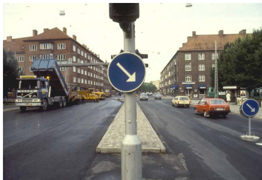
Bild 6. I tätorter är möjligheterna tillseparering av trafik och beläggningsarbete i allmänhet goda och borde tillämpas oftare.
