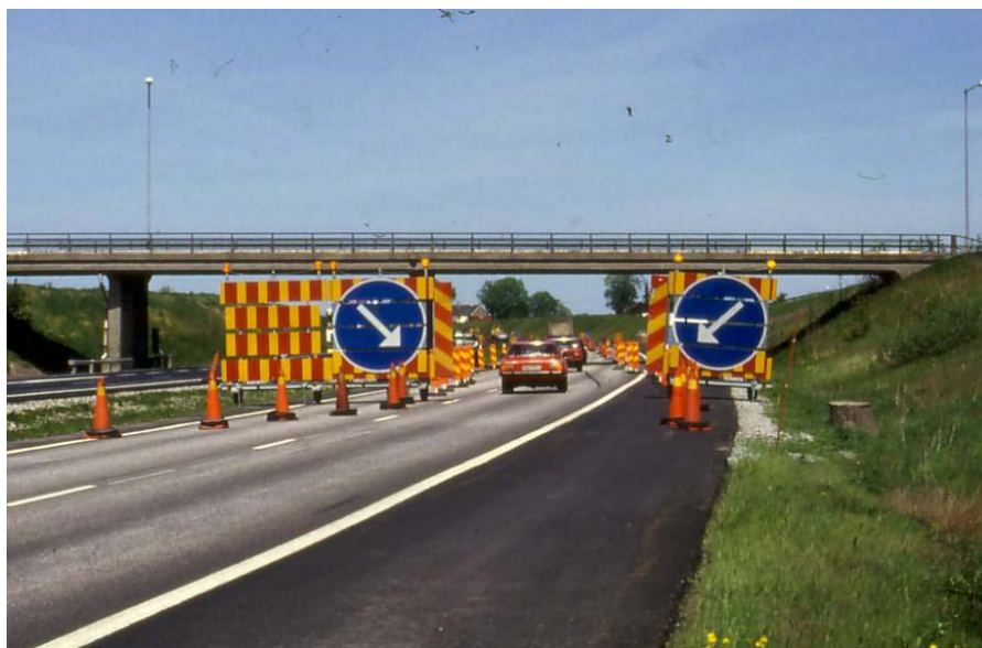
Bild 7. Alla beläggningsobjekt borde varslas lika omsorgsfullt som motorvägsarbeten.
