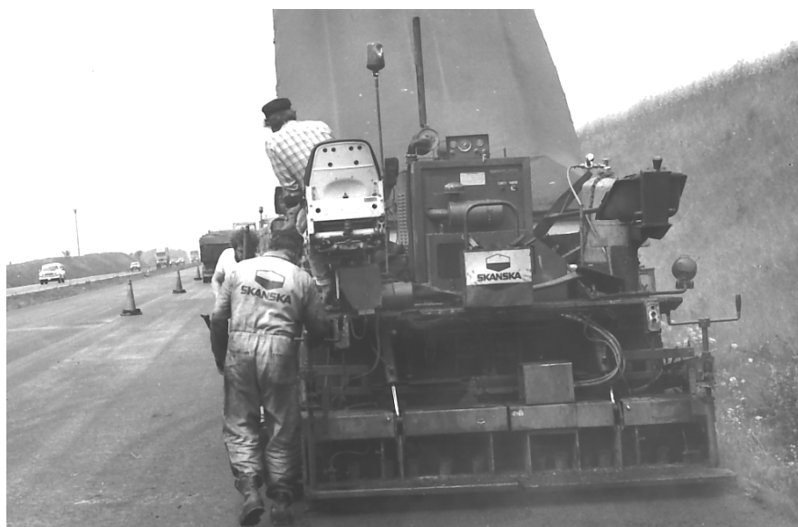
Bild 15. En av de viktigaste uppgifterna för en läggförrare är att framföra maskinen utefter en kant eller utlagt snöre. För att klara det måste han ibland inta en obekväm och påfrestande ställning.
