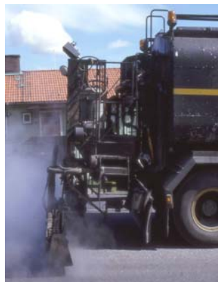
Bild 25. Allt oftare styrs spridningen av bitumen på ytbehandlingsarbeten från förarhytten. Rampoperatören slipper stå i ångorna. Jämnheten i spridningen bedöms av pågrusspridarens förare, som rapporterar resultatet via radio.
