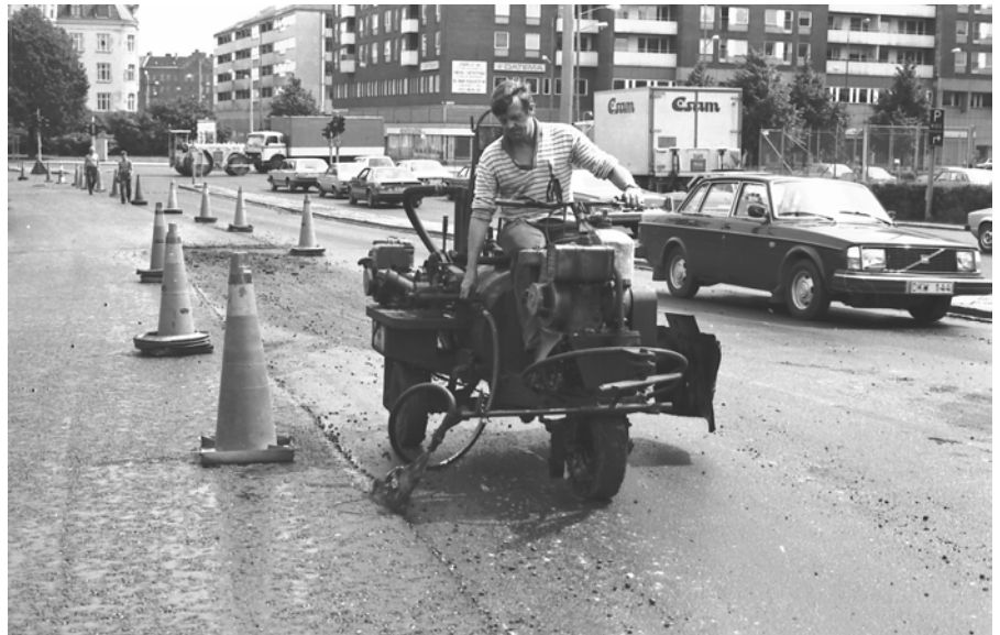
Bild 9. Klistringen görs i förväg, ofta ute bland trafikanterna. Momentet uppfattas som mycket störande av alla parter. Det skulle hjälpa om klistringen kunde nedbringas till de fall där det är helt nödvändigt.
