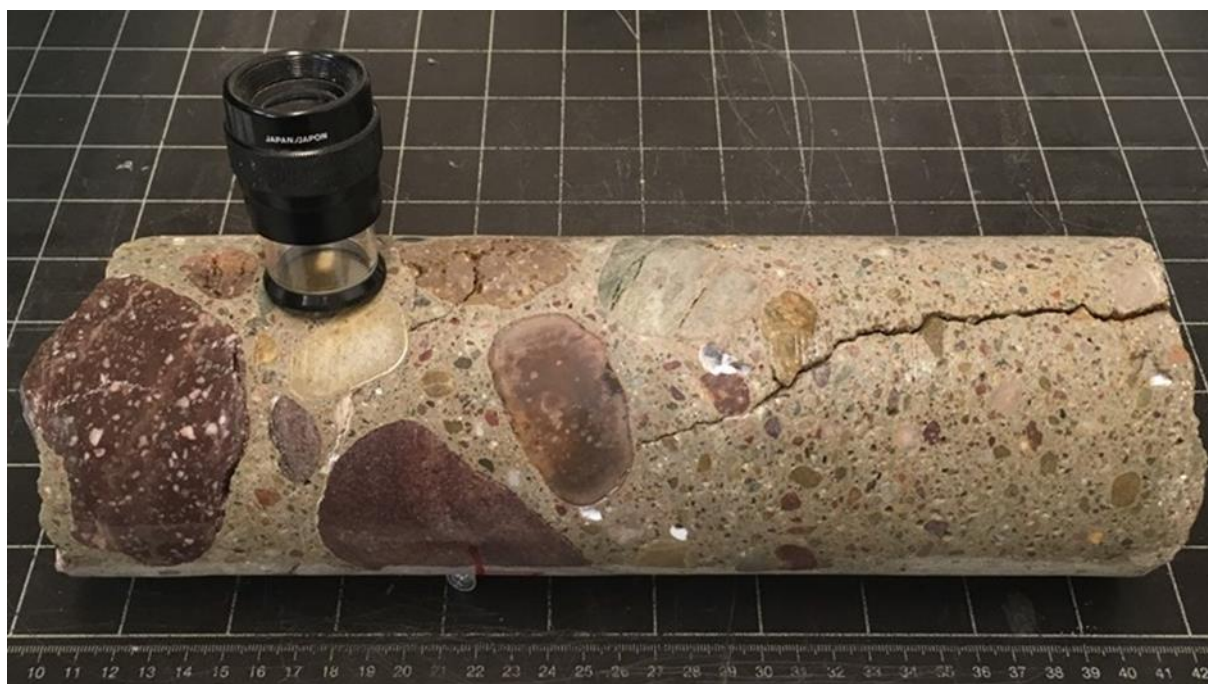
Figur 1. Okulär granskning av en borrhärna med hjälp av lupp. Luftporer är fyllda med vit alkalisilikagel och ballast visar sprickor karaktäristiska för ASR.
