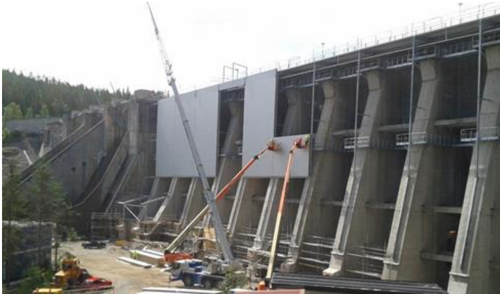
Figur 3.15 Montage av isoleringsvägg för att minska temperaturrelser på lamelldamm.
