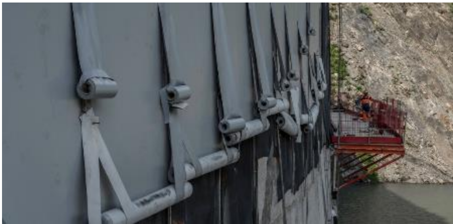
Figur 3.13 Försegling av uppströmssidan av damm med ytbeläggning.
