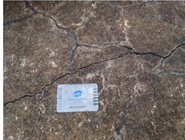
Figur 3.29 Mittbalkens övre yta.
