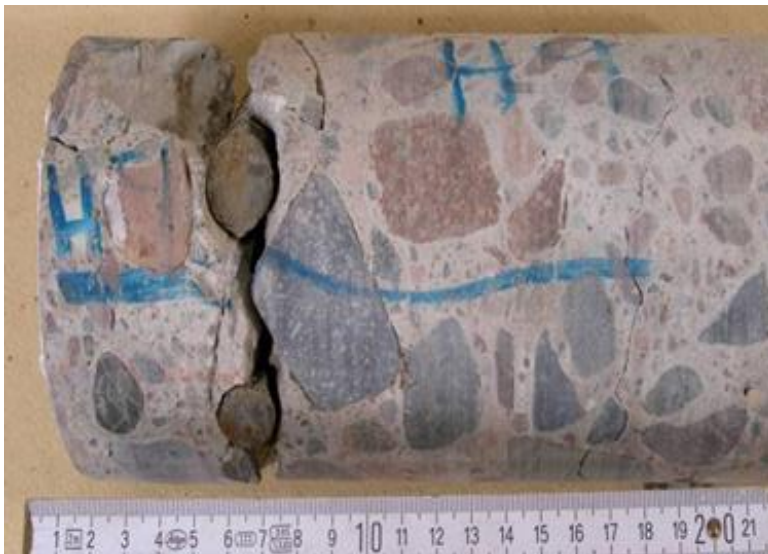
Figur 1.10 Expansion orsakad av ASR i riktning vinkelrätt mot armeringens längdriktning som har lett till delaminering av det täckande betongskiktet och nedsatt vidhäftning mellan armering och betong.
