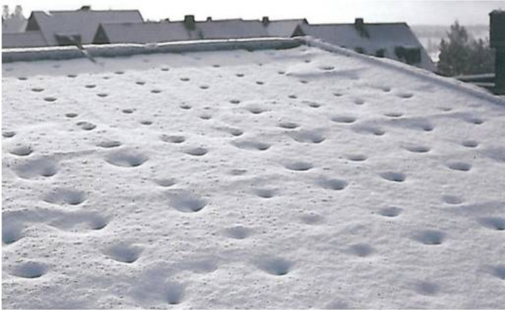
Figur 2 – Ett exempel på punktformiga köldbryggor i form av infästningar på ett tak. Foto: Ingemar Samuelson, SP.
