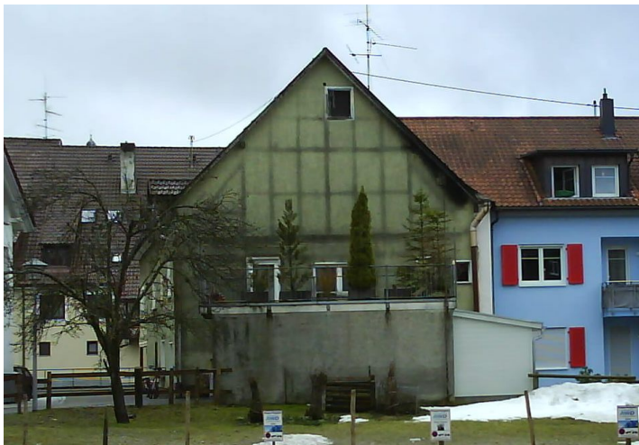
Figur 1 - Nedsmutsning av putsad fasad, en potentiellt negativ effekt av köldbryggor. Foto: Sonja Kildishev, Tyréns AB.
