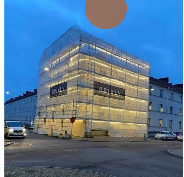
Exempel på inklädd byggnadsställning som minskar risken för olyckor.
