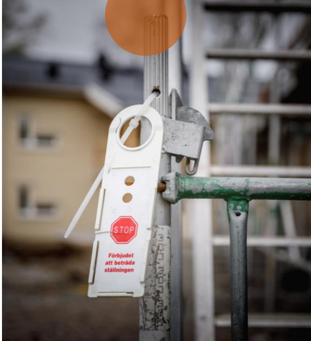
Låst grind som hindrar obehöriga och information om att det är förbjudet att beträda ställningen.
