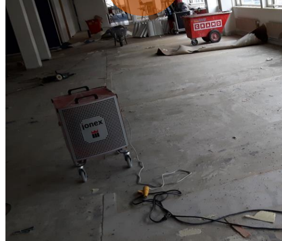
Här används en joniserande luftrenare vid rivning i befintlig fastighet.
