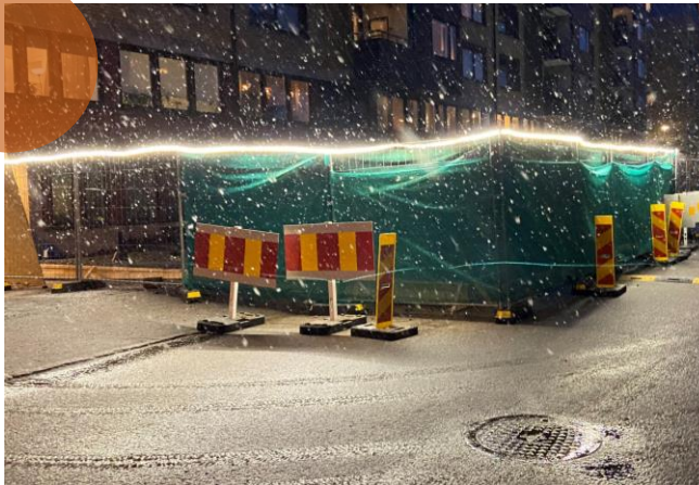
Ljusslingor som, förutom att ersätta gatubelysning som temporärt tagits bort, också markerar byggarbetsplatsen samt påverkar dess uttryck
