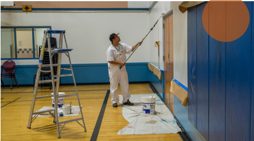
Eventuella negativa effekter av måleriarbeten kan minskas genom god ventilation och val av tidpunkt.
