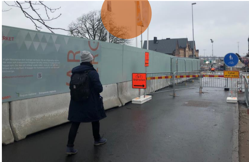
Tillfälliga vägs skyltar för fotgängare och cyklister. Beskrivning, samt QR-kod på plank för ytterligare information.
