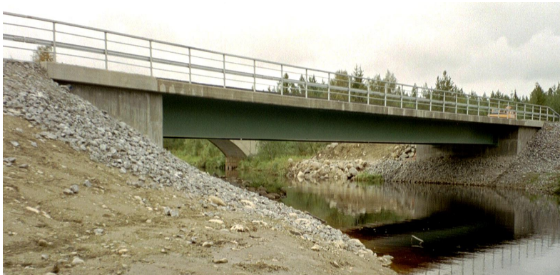
Figur 5 Bro över Fjällån efter uppförande, 2000.
