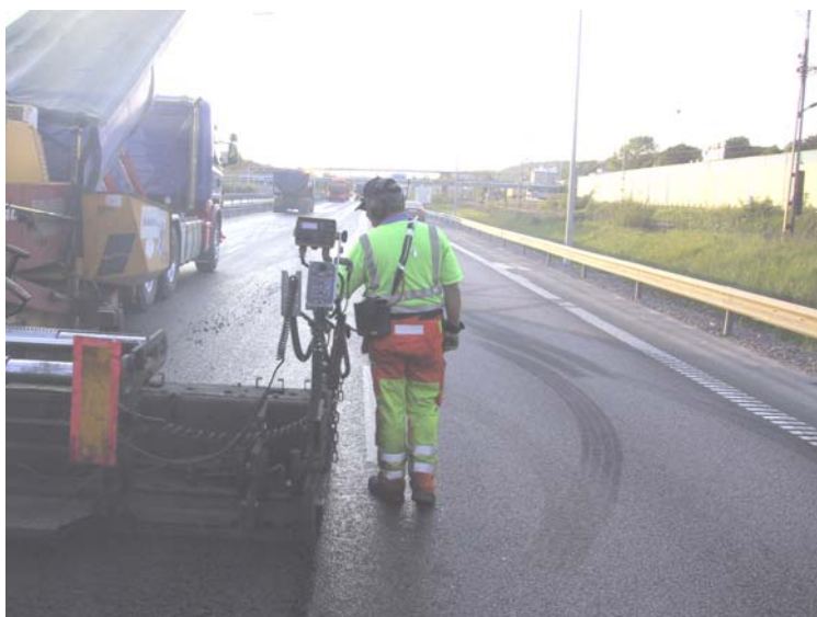
Bild 2 Mätutrustningen var fäst på asfaltarbetaren (personburen).
