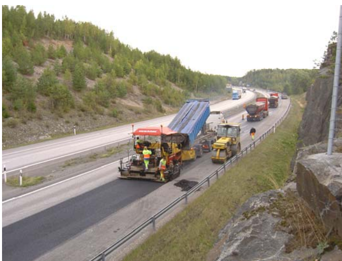
Bild 3 Utläggning av polymermodifierad asfaltmassa.
