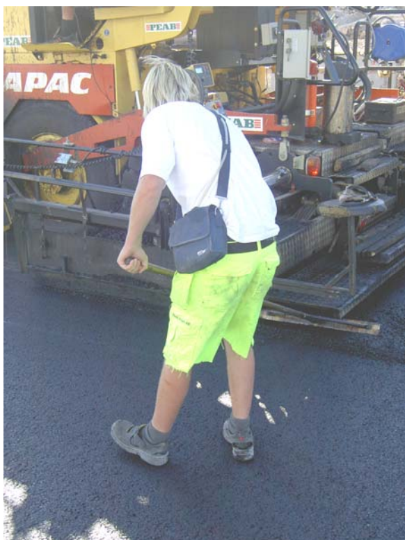
Bild 4 Mätutrustning monterad på asfaltarbetare.
