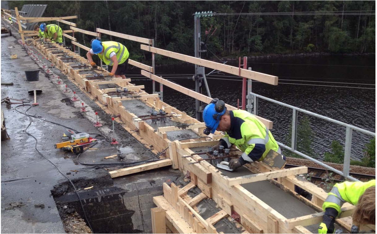
Figur 5.1 Detaljarbete med gjutning av kantbalk. Bro över Mellösasjön.
