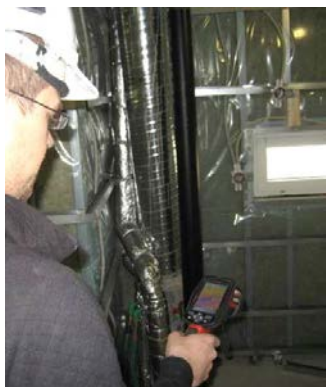
Läckagesökning med värmekamera, lufthastighetsmätare och rökgas.
