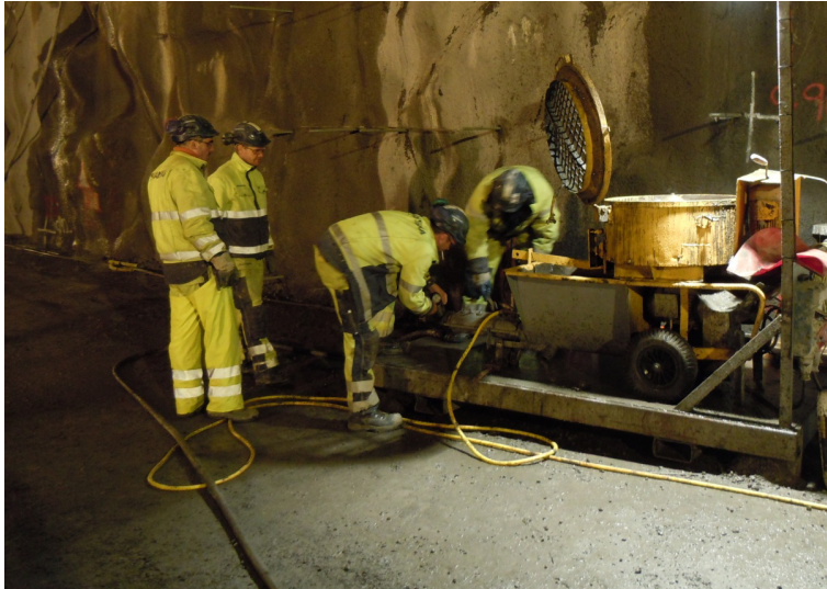
Arbetslag som monterade bultar
