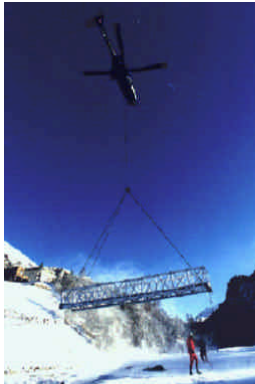
Figur 5.3 Flyttbar bro, Pontresina Schweiz. Källa: Fiberline [2002].
