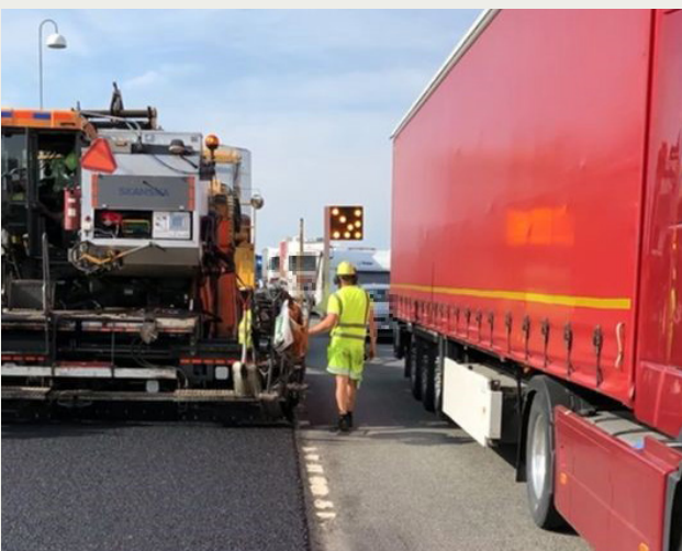
Figur 3. Visualisering av ljustavlan i användande under fyra oberoende vägarbetsplatser. Vägarbetarna har utrymme att med lätthet gå bredvid maskinen tack vare tavlans placering.
