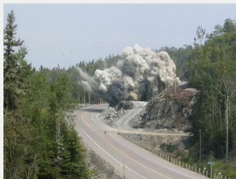
Figur 2. Bergsprängning av vägskärmning.
