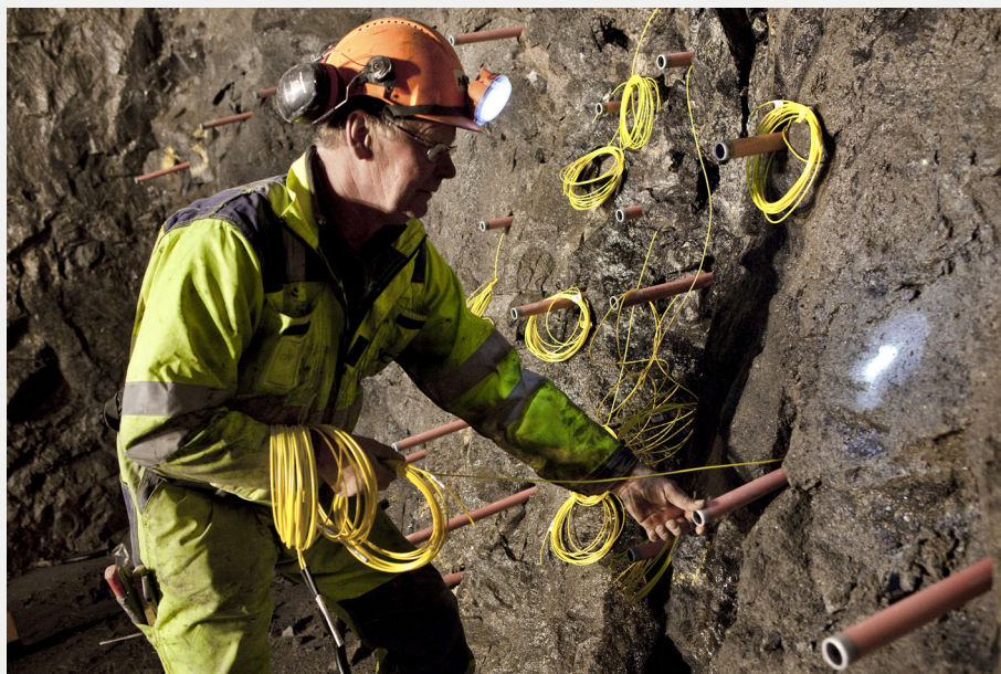
Figur 3. Förberedelser för sprängning vid Citybanan.
