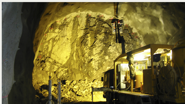
Figur 3. Injektering av skärm nr 2 i Sjöskullen Södra tunnel med både cement och silica sol. Vattenförlustutrustningen som användes syns i nedre vänstra delen av bilden.
