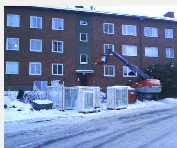
Mottagning på byggarbetsplats – avläsning och vidare logistik till mellanlagring innan montage. Alla steg avläses och dokumenteras med RFID-tekniken.
