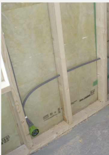
Figur 3. Exempel på indraget tätskikt (innan inre isolering är på plats).
