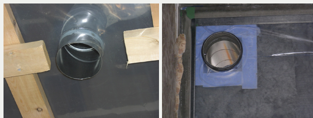
Figur 14 och 15. Exempel på genomföring med anpassad håltagning direkt i den uppspända plastfolien respektive exempel på genomföring med stos bestående av extra plastfolie som tejpas mot väggens plastfolie och mot röret.
