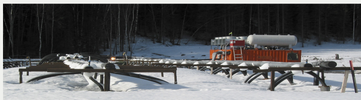
Figur 1. Artificiell frysning av jord på ett avsnitt av Botniabanan, cirka 1 mil nordost om Örnsköldsvik. På vänster sida, brinesystemet för de installerade frysrörerna i marken. På höger sida, kylmaskinerna, i bildens fond Stranneberget.
