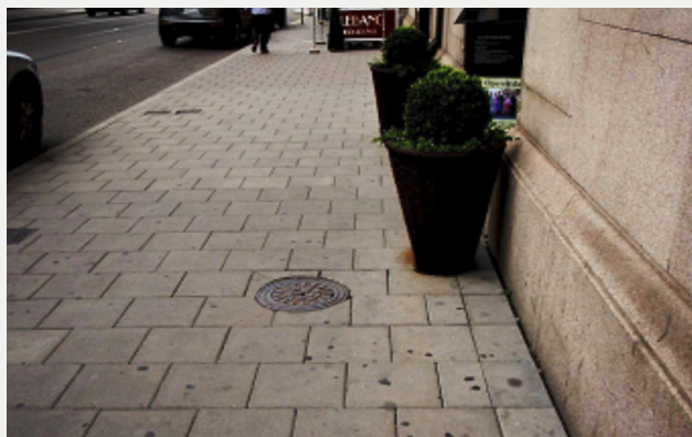
Figur 2. Placering av fältmättningsprover och var markstenen placerades och notera den ljusare markstensbeläggningen med 3 % \text{TiO}_2 .
