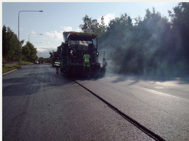
Fig 1. Läggnig av referensytan. Observera asfaltröken.
