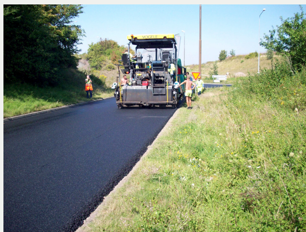
Fig 2. Läggnig av asfaltmassa med Rediset WMX. Ingen synlig asfaltrök.
