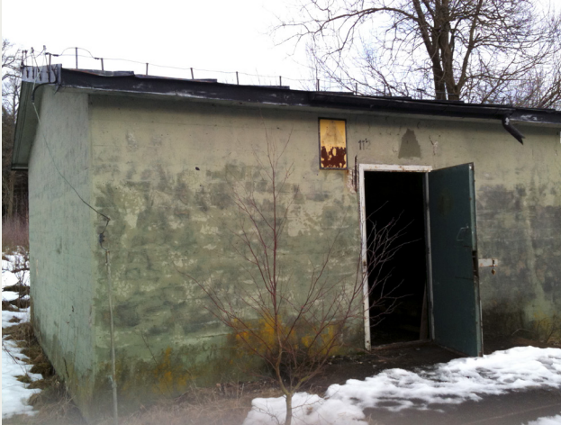
Bild 1. Tjärbestruket förråd (insida och grund).
