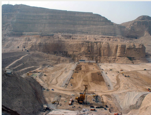
Figur 1. Gotvand dammen i Iran under byggnation
