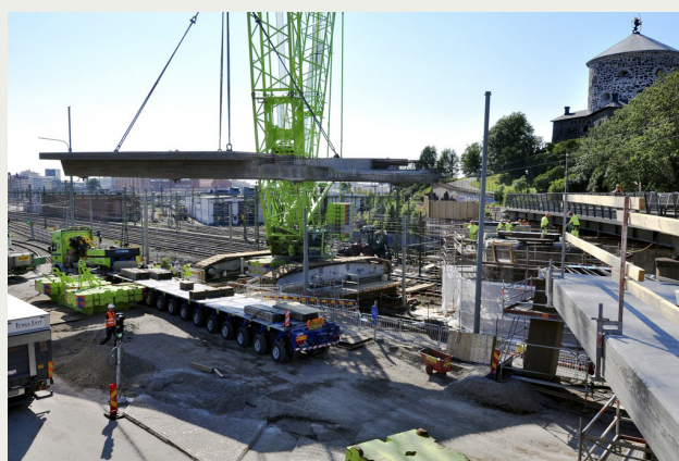
En brosektion lyftes på plats med kran för brobyten över Svingeln i Göteborg (Foto: A. Nikolis)
