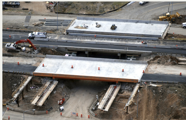
Installation av två broar med två olika sidolanseringmetoder (Foto: Freyssinet)
