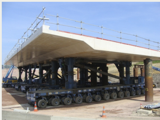
Installation av Sam White bron med Self-Propelled Modular Transporters (Foto: Sarens)
