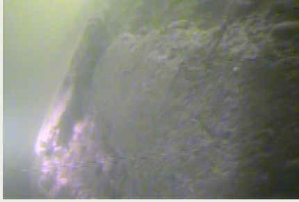
Figur 1. Ballast och ingjutet stål gods har frilagts vid vattenlinjen på nedströmssidan av ett vattenkraftverk (vänster bild). Löst hängande betongsjok på uppströmssidan av en tunn valvdamm i betong (höger bild).
