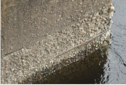
Figur 1. Ballast och ingjutet stål gods har frilagts vid vattenlinjen på nedströmssidan av ett vattenkraftverk (vänster bild). Löst hängande betongsjok på uppströmssidan av en tunn valvdamm i betong (höger bild).
