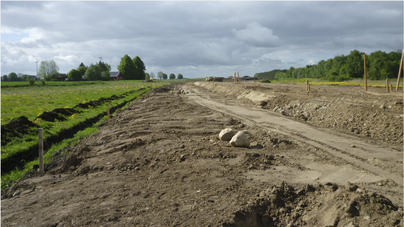
Förbelastning på Rv 50 Mjölby – Motala. Överlasten är utlagd över färdig vägbredd med anslutande tryckbankar för att tillfredställande säkerhet mot stabilitetsbrott ska föreligga under den stegvisa uppbyggnaden.
